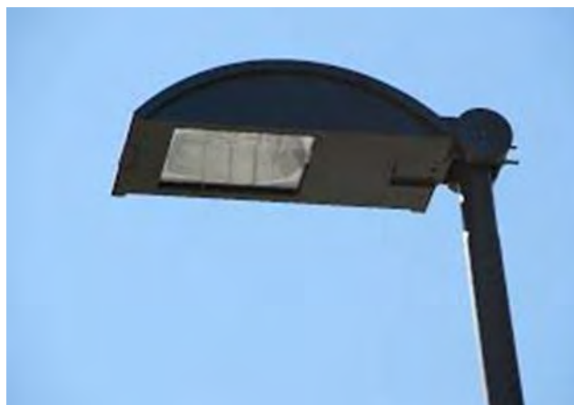
Figura 4.51: Esempio di apparecchio completamente schermato (full-cut-off)
