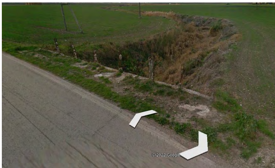
Figura 4.49: Esempio di fosso interpoderale che sarà attraversato dalla linea di connessione
