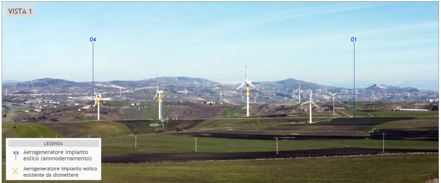
Figura 2 – Punto di vista aereo 1
