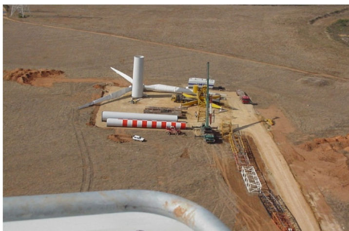
Figura 7 – Piazzola per il montaggio dell'aerogeneratore
