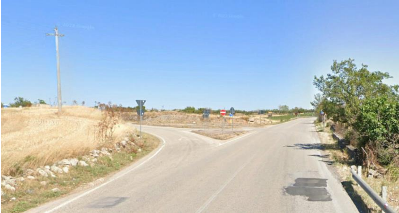
Figura 5 – SVINCOLO DELLA STRADA PROVINCIALE 41 "Carpetino"
