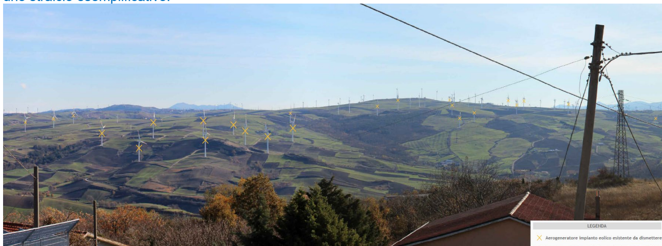
Stato di Fatto, con aerogeneratori da dismettere
