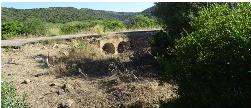
Figura 3-9: opere di gestione dei deflussi torrentizi
