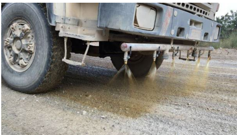
Figura 98 - Esempio di bagnatura delle piste di cantiere attraverso nebulizzatore mobile
