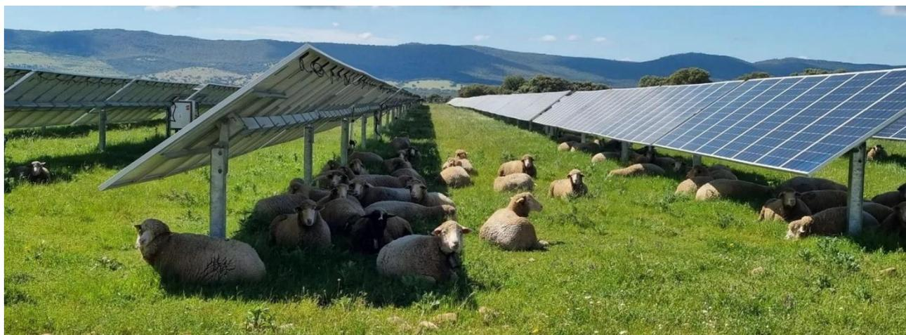
Figura 4 Esempio di tracker monoassiale montante una fila di moduli bifacciali
