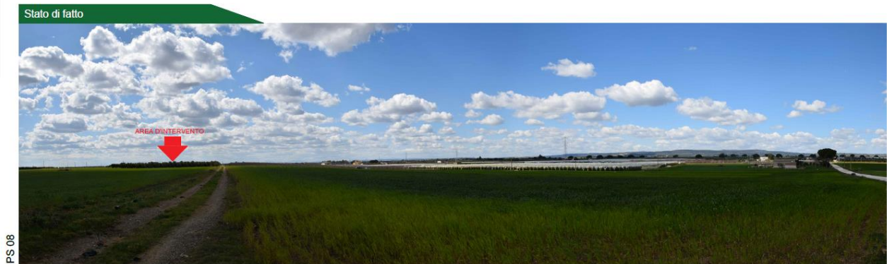
Fig. n. 8 Punto sensibile n. 8 Stato di fatto A destra impianto esistente al suolo
