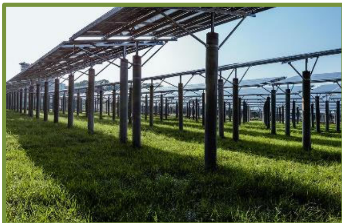
Figura 137: esempio di corridoio ecologico con elevata valenza L'area sottostante ai tracker fotovoltaici anche se ritenuta una tara agricola è comunque un'area in cui cresce il prato
