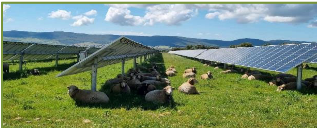
Figura 121: convivenza tra ovini e impianto fotovoltaico
