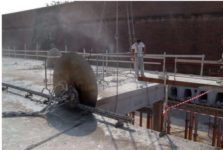
Figura 11 – Esempio taglio travi con sega circolare diamantata
