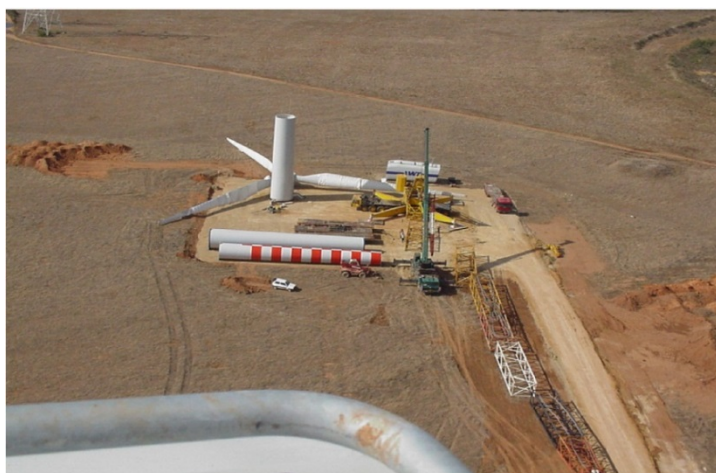
Figura 7 – Piazzola per il montaggio dell'aerogeneratore
