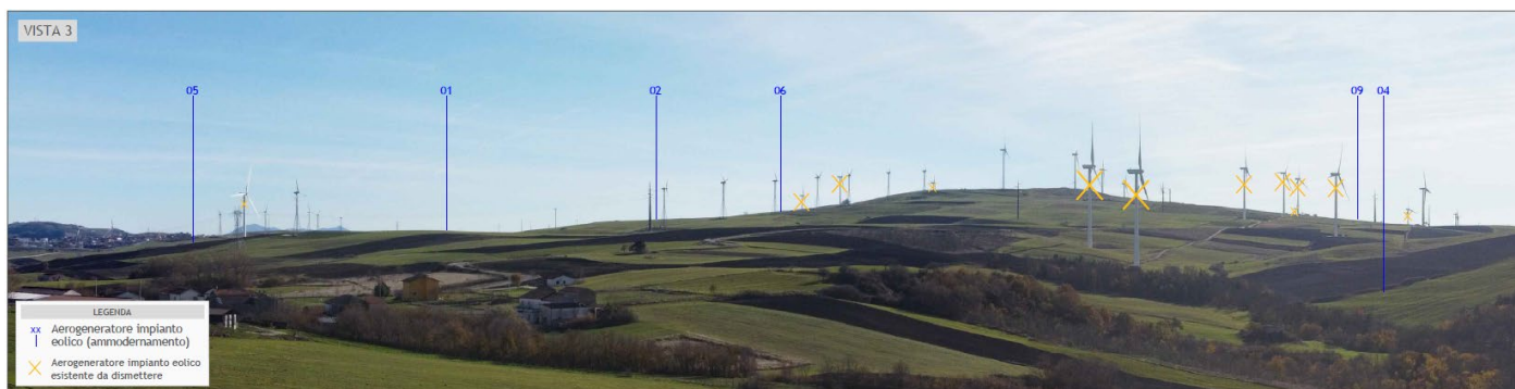
Figura 4 – Punto di vista aereo 3
