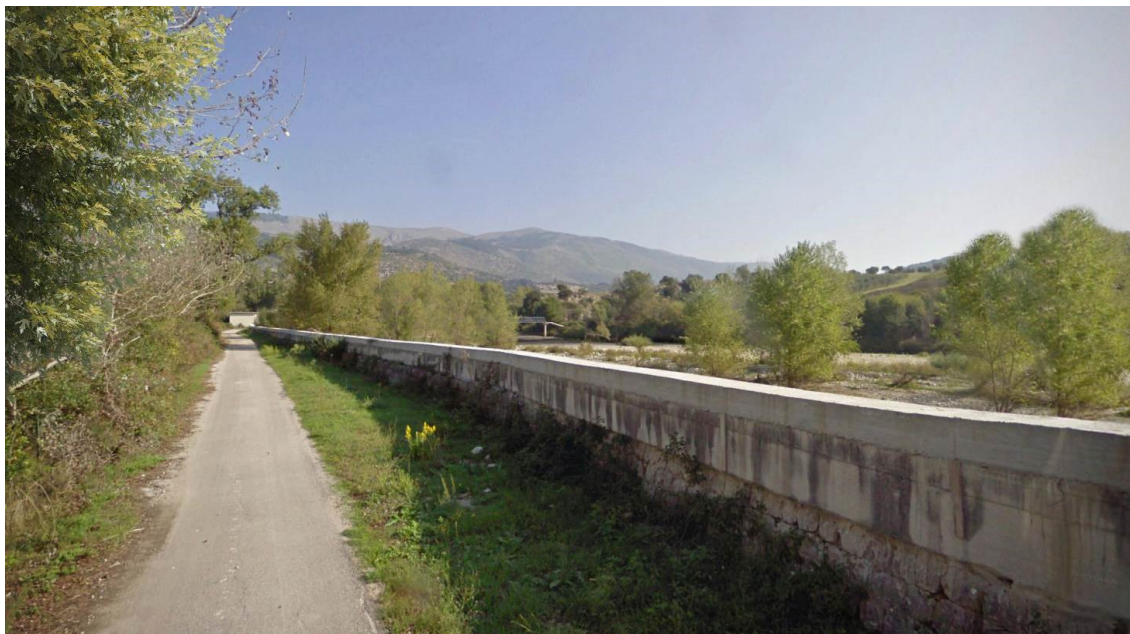
Figura 6-3. Foto ante operam del tratto in cui la linea attraversa il Fiume Bianco
