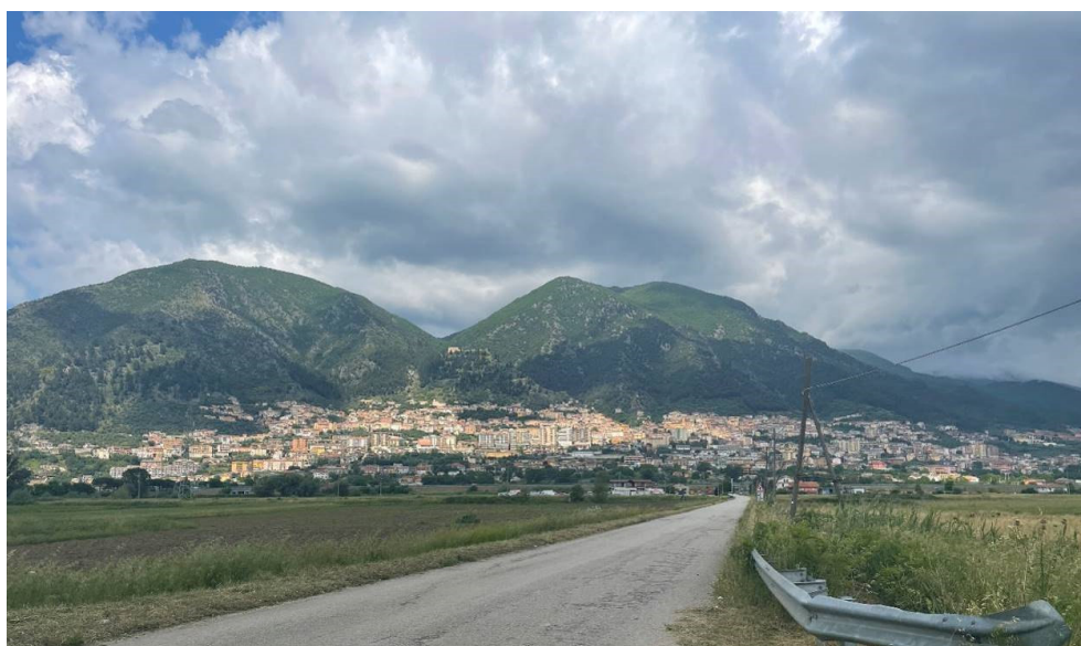
Figura 6-5. Foto ante operam del tratto in cui la linea attraversa il Vallo di Diano con il viadotto VI04
