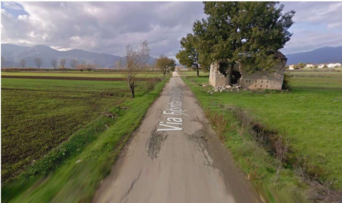
In funzione delle caratteristiche della viabilità esistente l'intervento denominato NV39 è stato inquadrato come strada locale a destinazione particolare con larghezza della sezione pari a 6.50 m (corsie da 2.75m e banchine da 0.50m).
