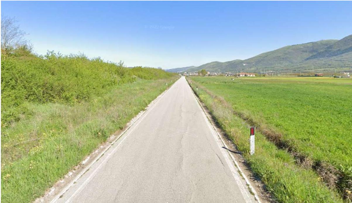
In funzione delle caratteristiche della viabilità esistente l'intervento denominato NV36 è stato inquadrato come strada locale a destinazione particolare con larghezza della sezione pari a 6.50 m (corsie da 2.75m e banchine da 0.50m).
