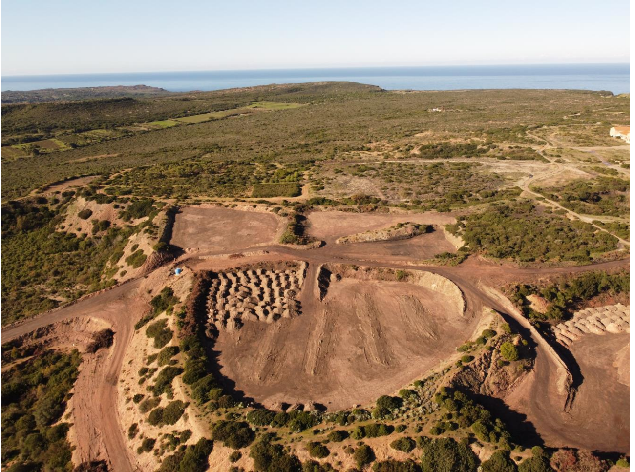
La stessa area dopo il disboscamento.
