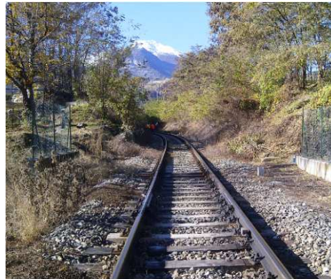
Impianto lubrificazione P.A.L. Italia (Foto: P.A.L. Italia; 2012)
