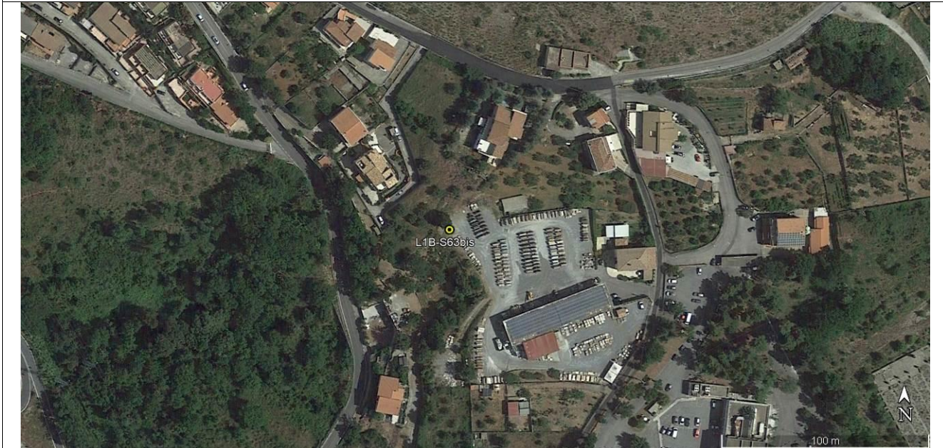
Ubicazione da foto aerea (Google Earth) - Scala grafica
