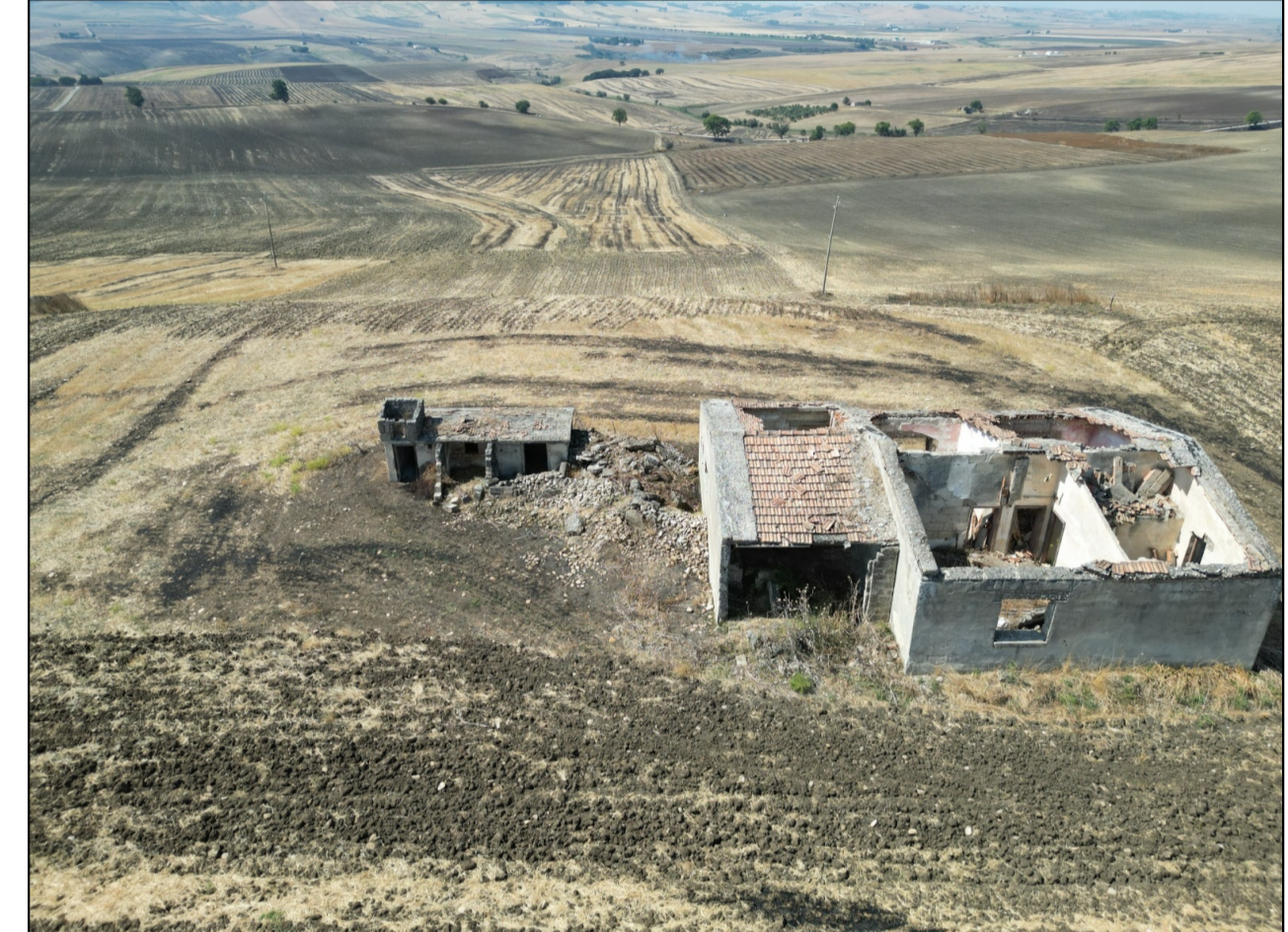
F6_FOTO DETTAGLIO 2 EDIFICIO 6
