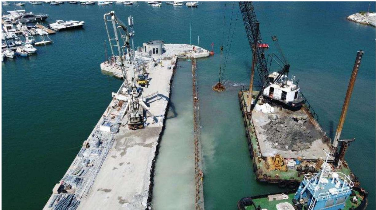
*Foto 57: 10.07.2023 – Molo Langano: scavi di rifilatura fondale*
