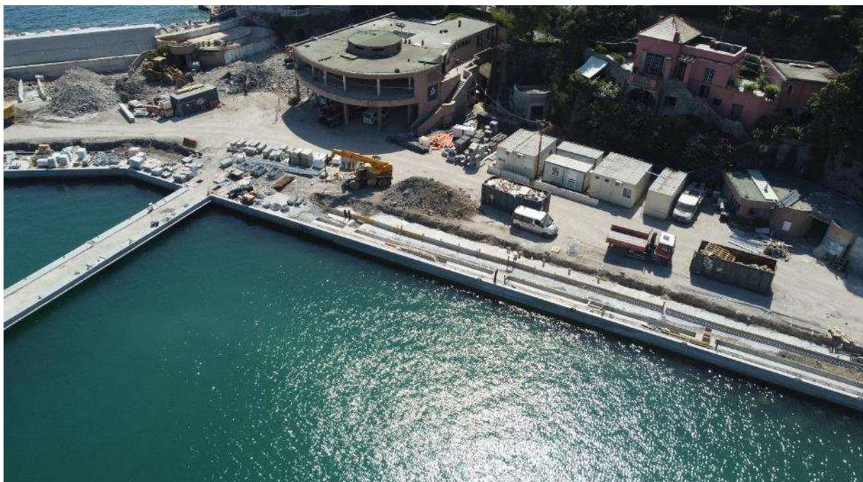
*Foto 56: 10.07.2023 – realizzazione parti posteriori del cordolo banchina piazzale*
