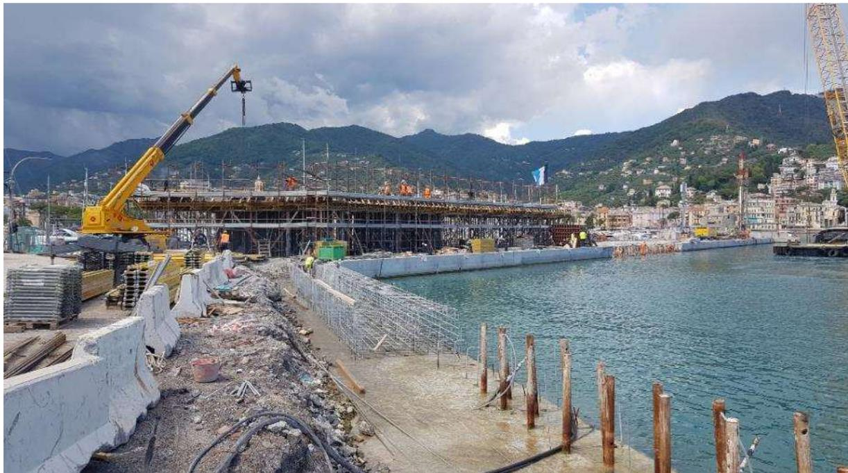
*Foto 23: 15.05.2023 – vista del cordolo banchina piazzale in costruzione*
