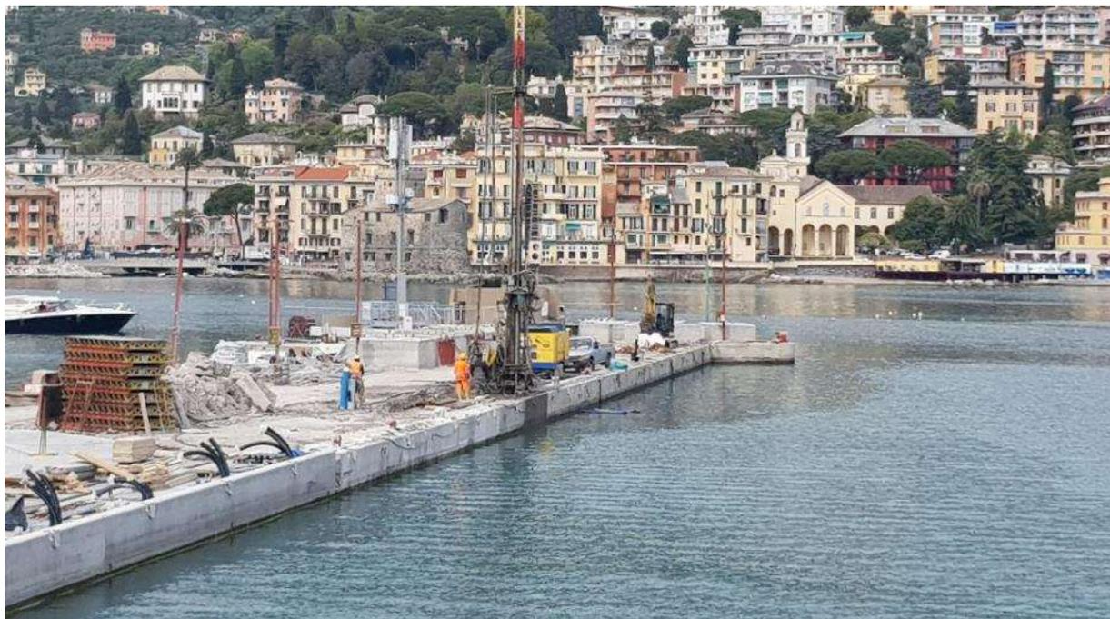
*Foto 14: 27.04.2023 – vista del Molo Langano (consolidamento banchina con jet grouting in corso)*
