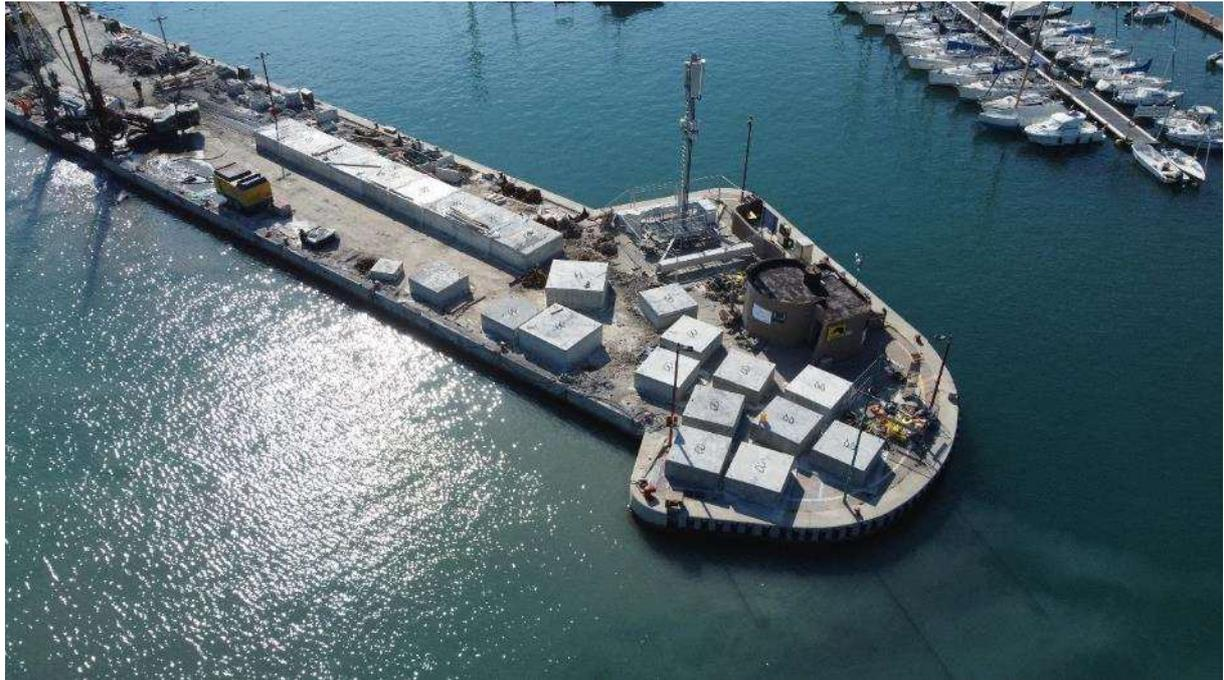
*Foto 15: 04.05.2023 – testata Molo Langano con corpi morti pronti per la posa*
