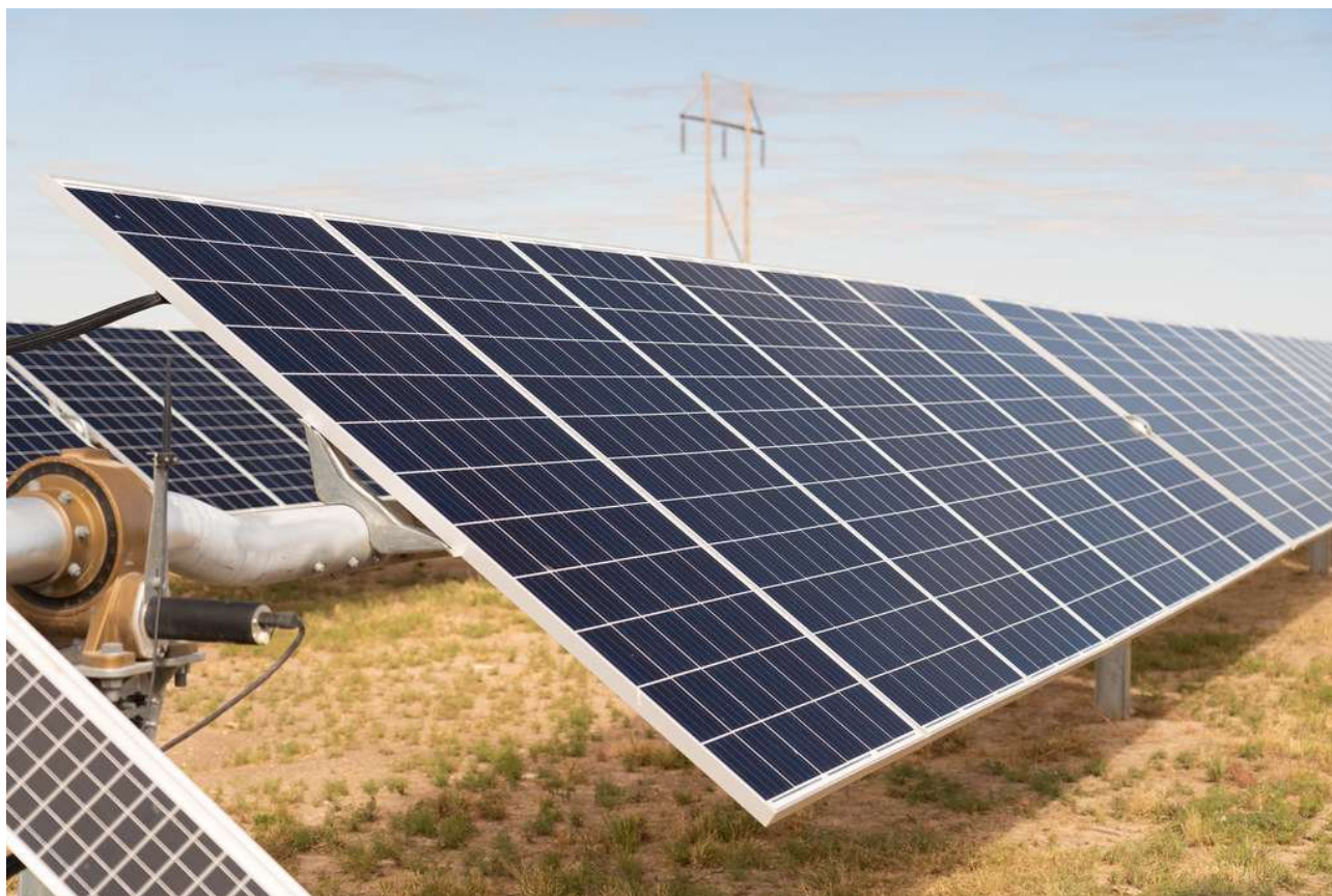
Figura 15 - Esempio di tracker monoassiale monofila montante moduli bifacciali;
