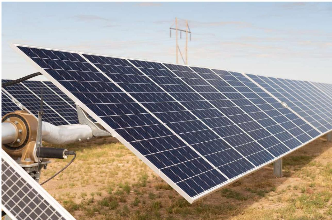
*Figura 17 - Esempio di tracker monoassiale monofila montante moduli bifacciali;*
