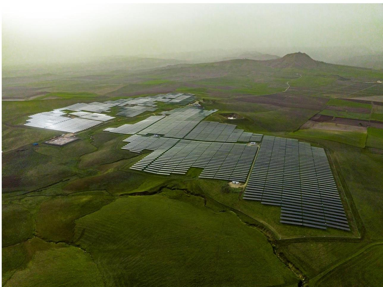
*Figura 11 Esempio di un campo fotovoltaico monoassiale (inseguimento a Rollio)*
