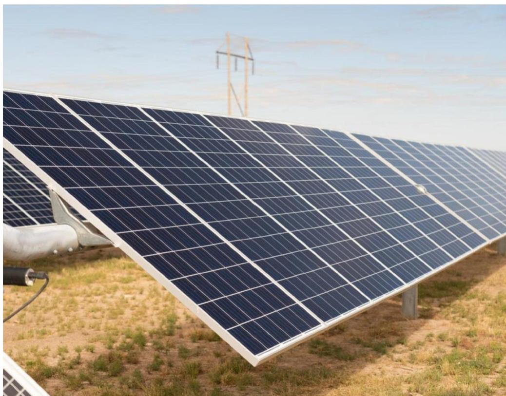
Figura 13 Esempio di tracker monoassiale monofila montante moduli bifacciali
