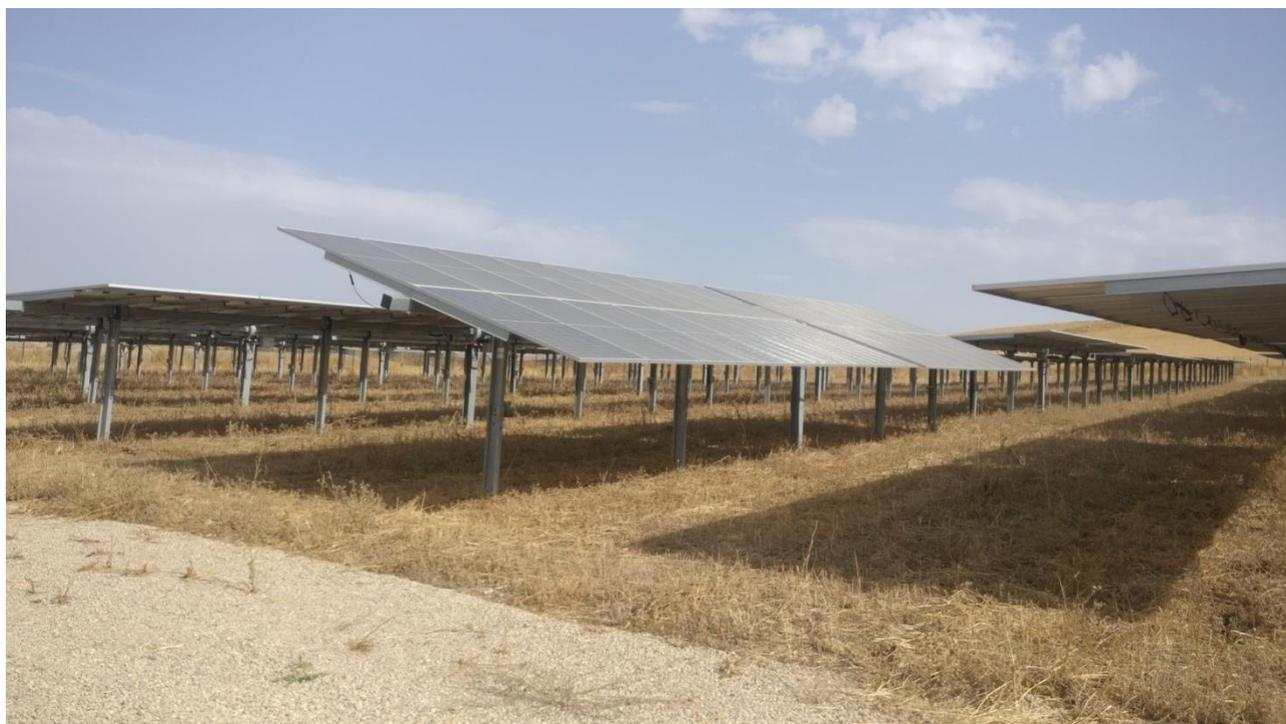
*Figura 59 Esempio d'impianto monoassiale (inseguitore di Rollio)*
