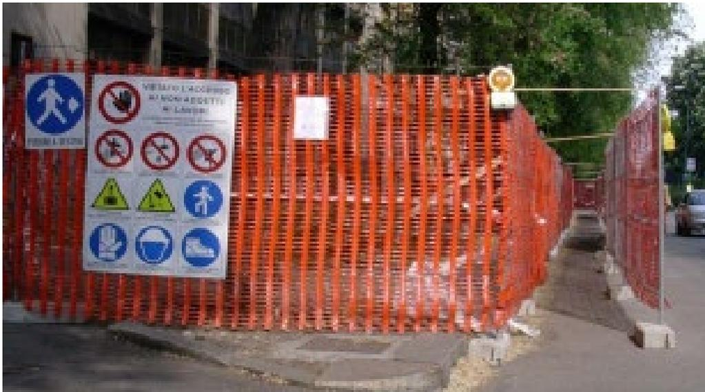
Foto 3-1: Esempio di recinzione in rete zincata con integrazione di rete in PVC a maglia ovoidale
