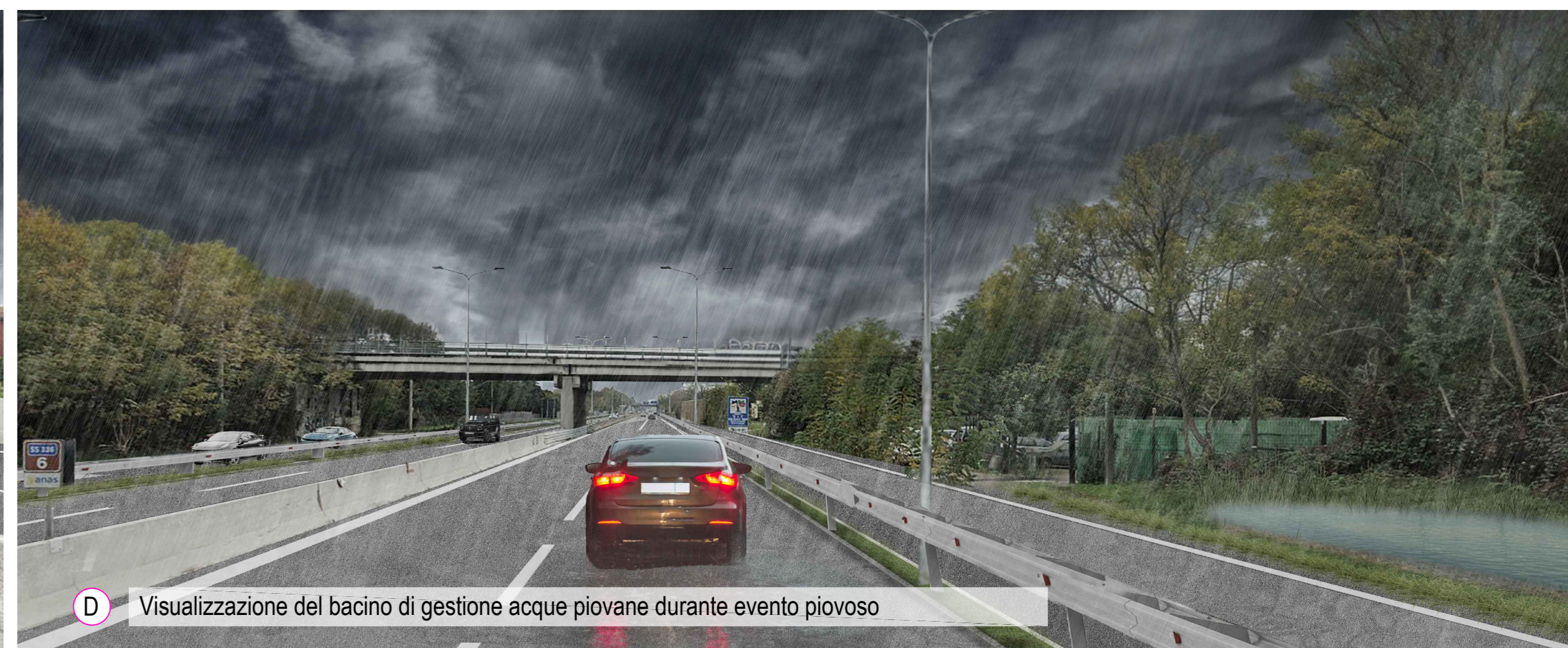
D Intervento di riposizionamento corpi illuminanti, ampliamento stradale, aggiornamento barriere di sicurezza stradale ed antirumore, inserimento di bacini per gestione acque piovane
