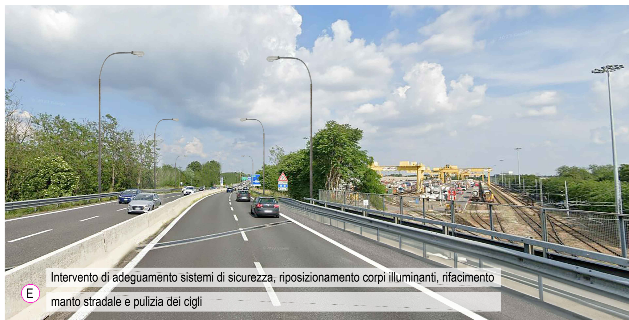
B Intervento di riposizionamento corpi illuminanti, ampliamento stradale, aggiornamento barriere di sicurezza stradale ed antirumore, mitigazione paesaggistica tramite opere a verde
