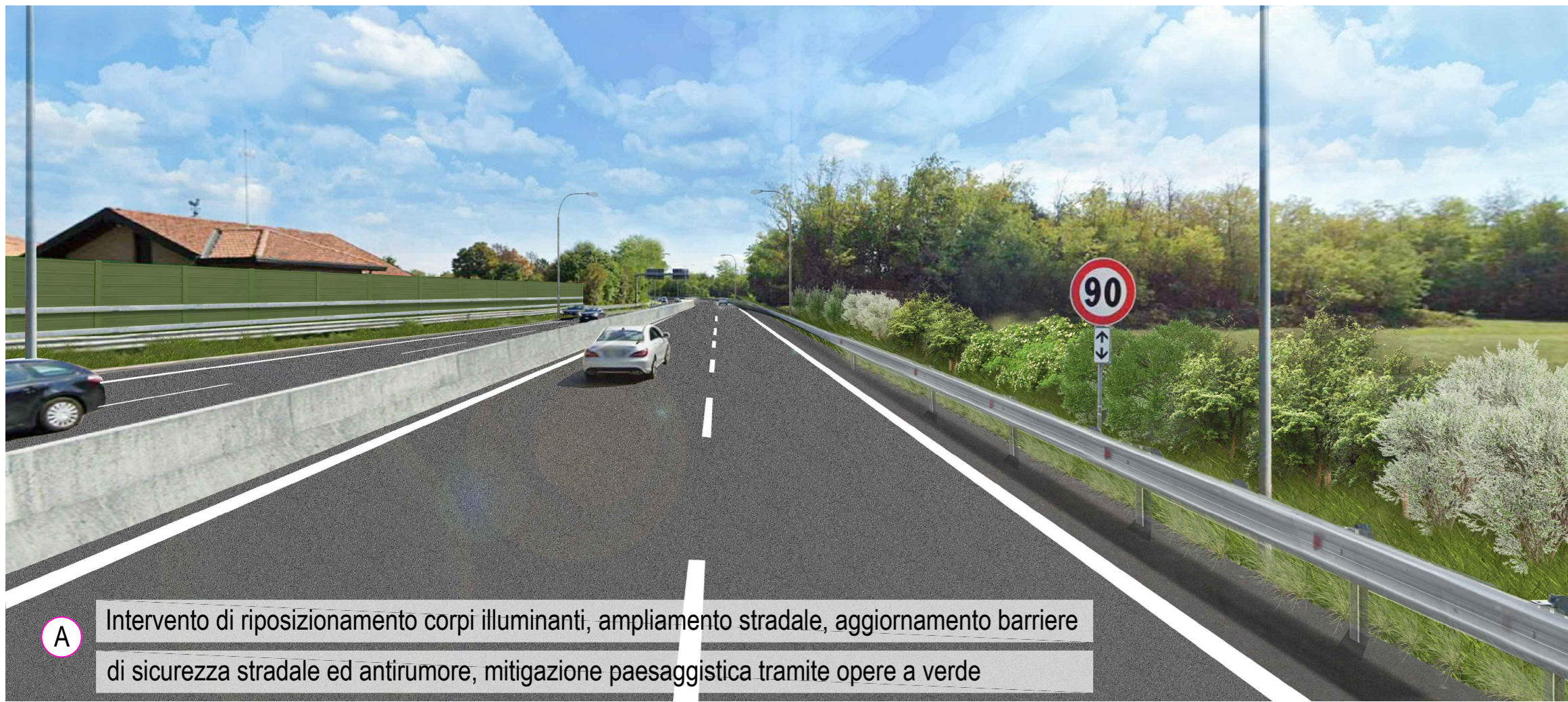
B Intervento di riposizionamento corpi illuminanti, ampliamento stradale, aggiornamento barriere di sicurezza stradale ed antirumore, mitigazione paesaggistica tramite opere a verde
