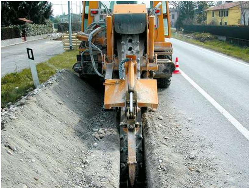
Figura 7-1. Esempio di mezzo di piccole dimensioni per la realizzazione dello scavo per la posa del cavidotto.
