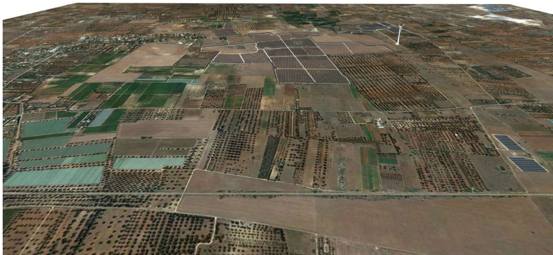
Figure 5-23. Veduta generale dell'intervento
