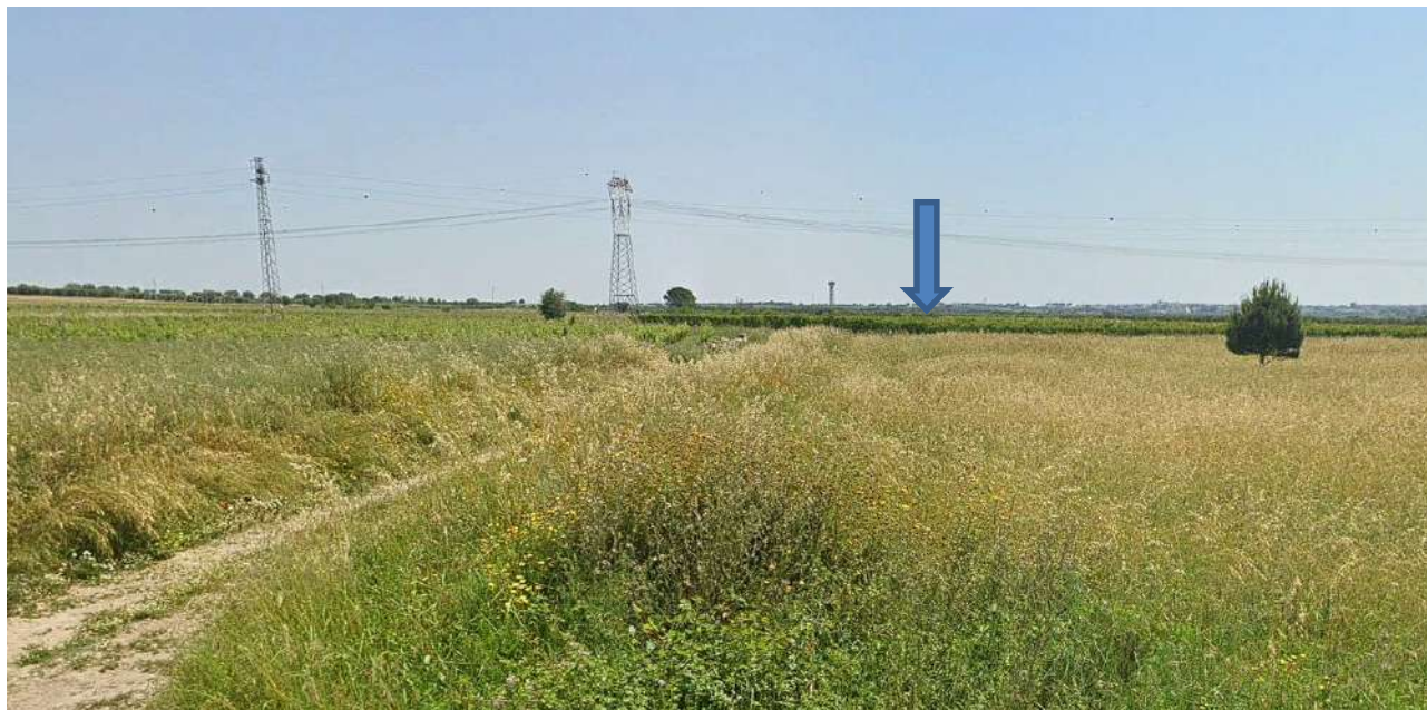
Figura 5-9: Estratto fotografico relativo al punto di connessione dell'elettrodotto interrato che sarà allacciato, nel comune di Taranto (TA), alla Rete di Trasmissione Nazionale (RTN) in antenna a 36 kV su una futura Stazione Elettrica (SE) di trasformazione della RTN da inserire in entra-esce alla linea 380 kV "Erchie 380 – Taranto N2" oggetto di altro procedimento amministrativo.
