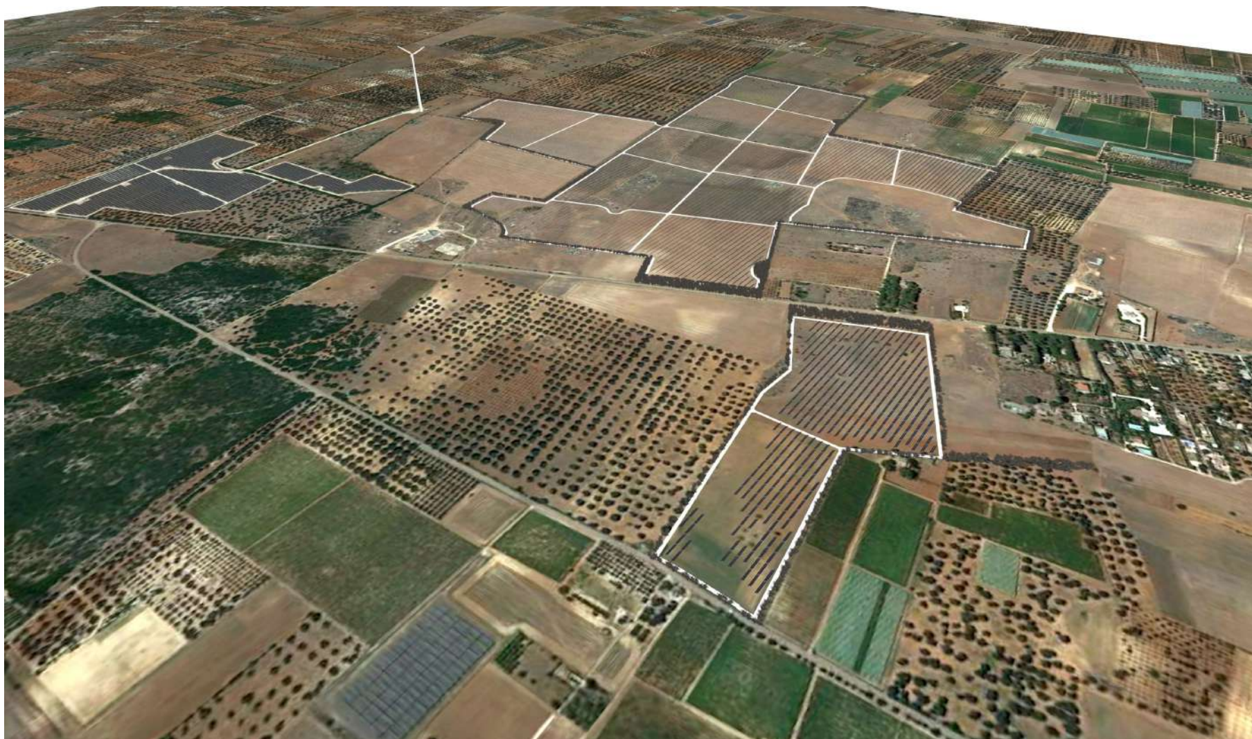
Figure 5-24. Veduta Generale dell'intervento
