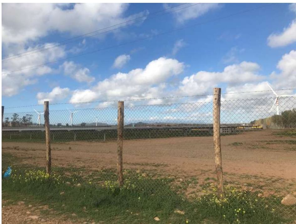
Figure 2-12. Tipologia di recinzione utilizzata
