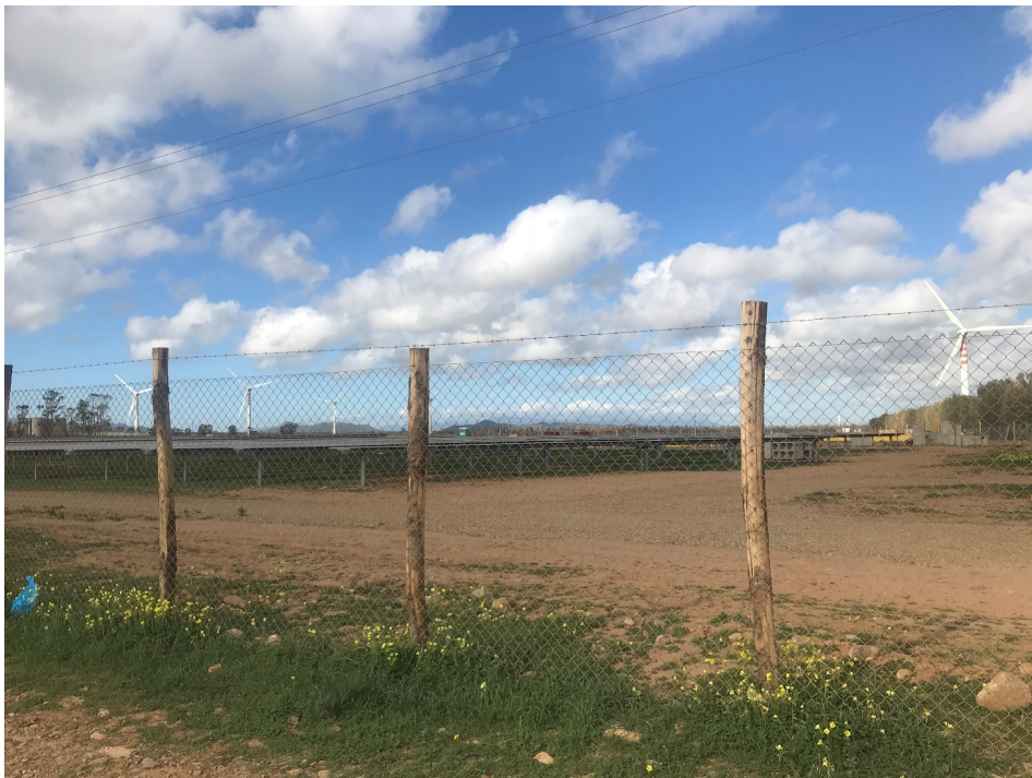
Figure 1-11. Tipologia di recinzione utilizzata
