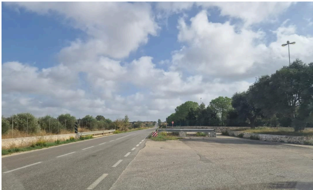
Foto 5 (interferenza con tombino stradale)
