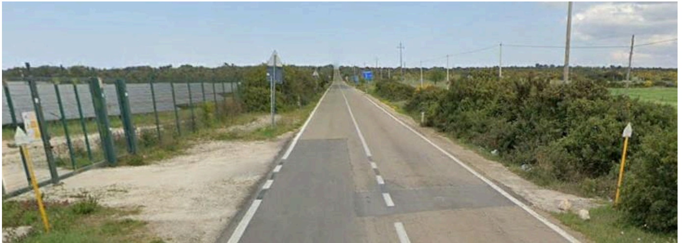
Foto 3 (interferenza con elettrodotto interrato)
