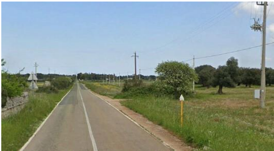
Foto 2 (interferenza con elettrodotto interrato)
