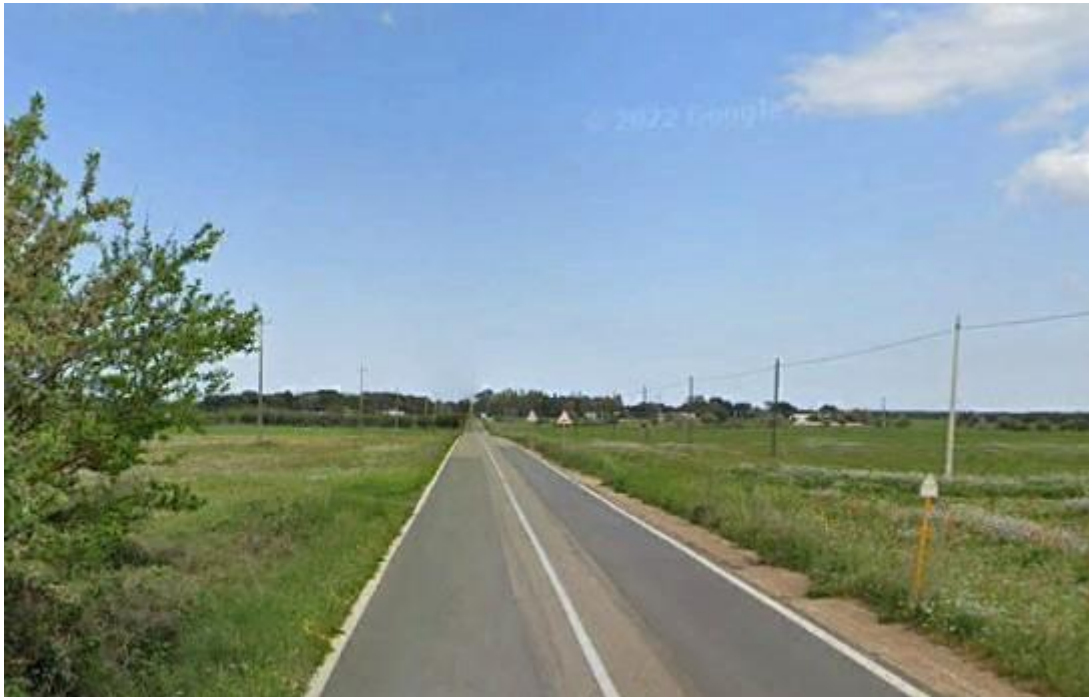
Foto 1 (interferenza con elettrodotto interrato)
