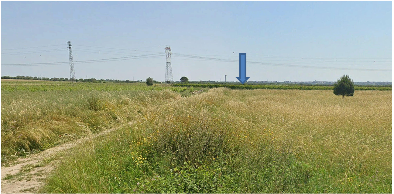
Figura 25: Estratto fotografico relativo al punto di connessione dell'elettrodotto interrato che sarà allacciato, nel comune di Taranto (TA), alla Rete di Trasmissione Nazionale (RTN) in antenna a 36 kV su una futura Stazione Elettrica (SE) di trasformazione della RTN da inserire in entra-esce alla linea 380 kV "Erchie 380 – Taranto N2" oggetto di altro procedimento amministrativo.
