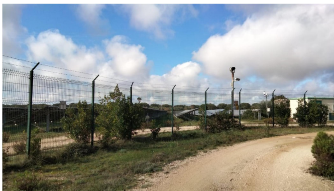
Figura 5-12: Estratto fotografico del campo fotovoltaico prospiciente l'area di indagine
