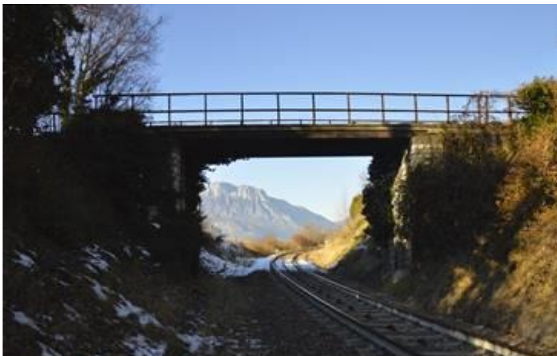
Figura 6.3 – Sovrappasso Povo – opera da demolire
