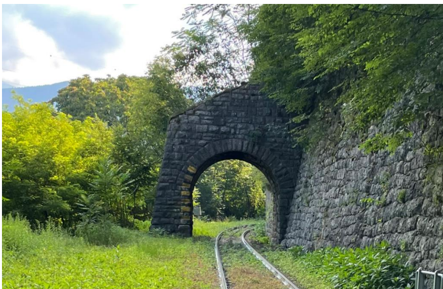
Figura 6.2 – Scivolo legname – opera da demolire
