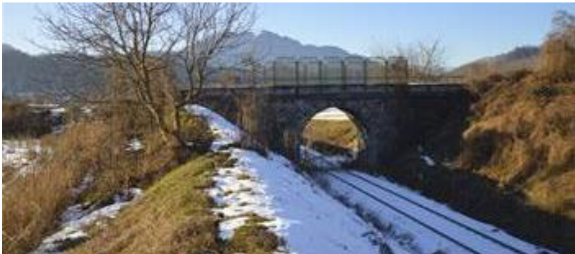
Figura 6.1 – Sovrappasso via Levico – opera da demolire
