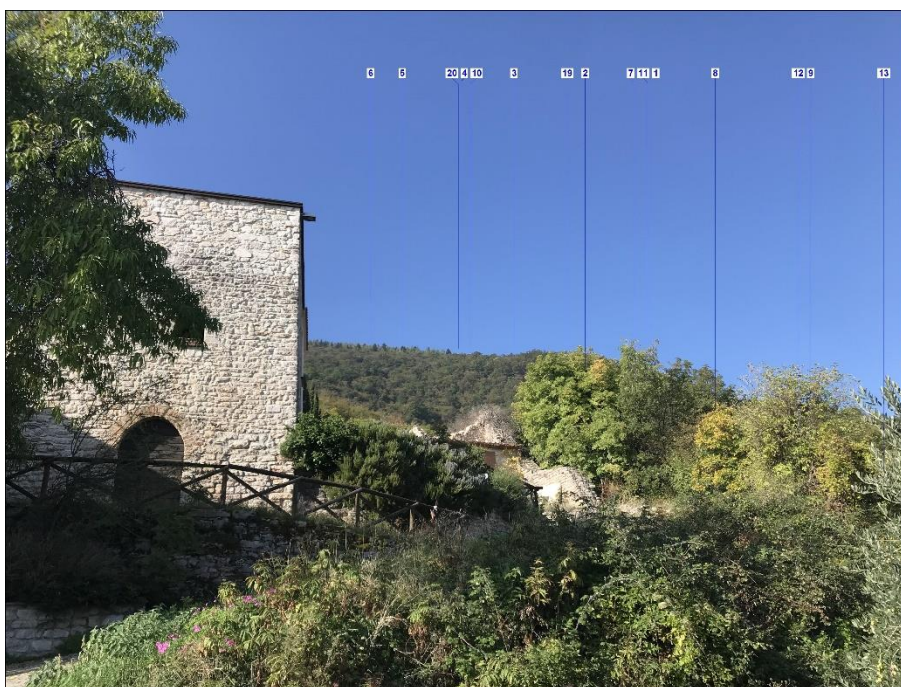
Figura 20– Punto POV5, Caldarola, Castello di Vestignano. (foto in direzione ovest sud-ovest). Rappresentazione fotografica ante operam e fotoinserimento.
