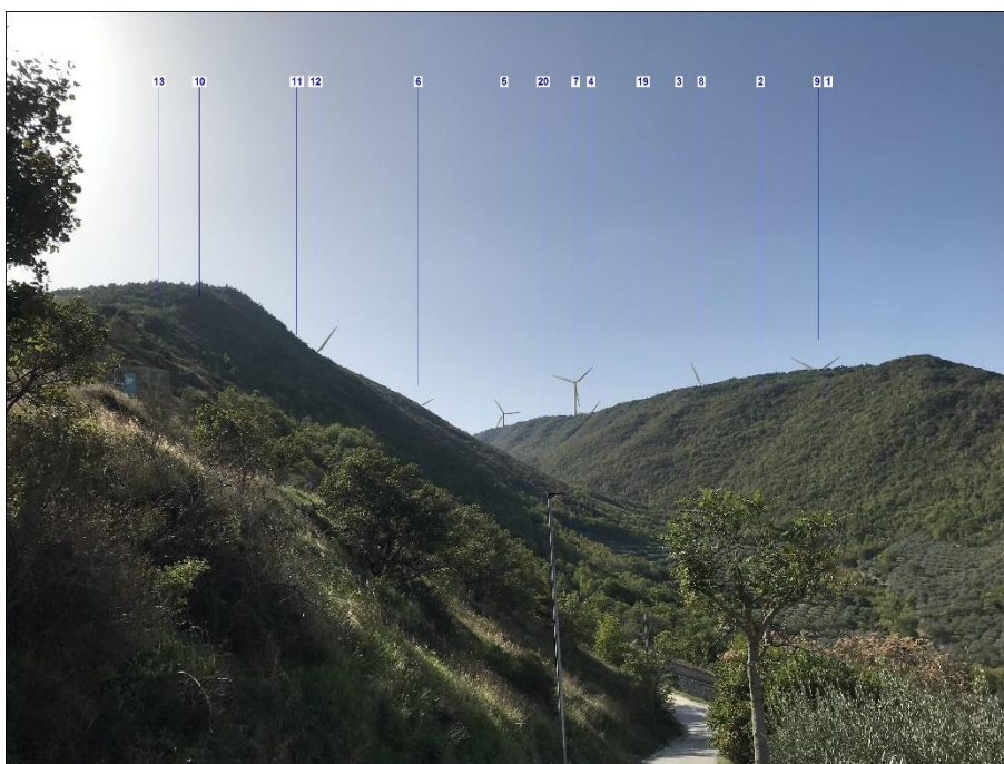
Figura 22– Punto POV7, Caldarola, Antiquarium di Pievefavera, (foto in direzione sud sud-ovest). Rappresentazione fotografica ante operam e fotoinserimento.
