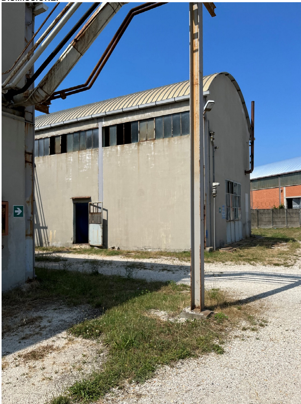
FOTO 6 – STRUTTURA PER PRODUZIONE DI ACQUA DEMINERALIZZATA IN DISMISSIONE.
