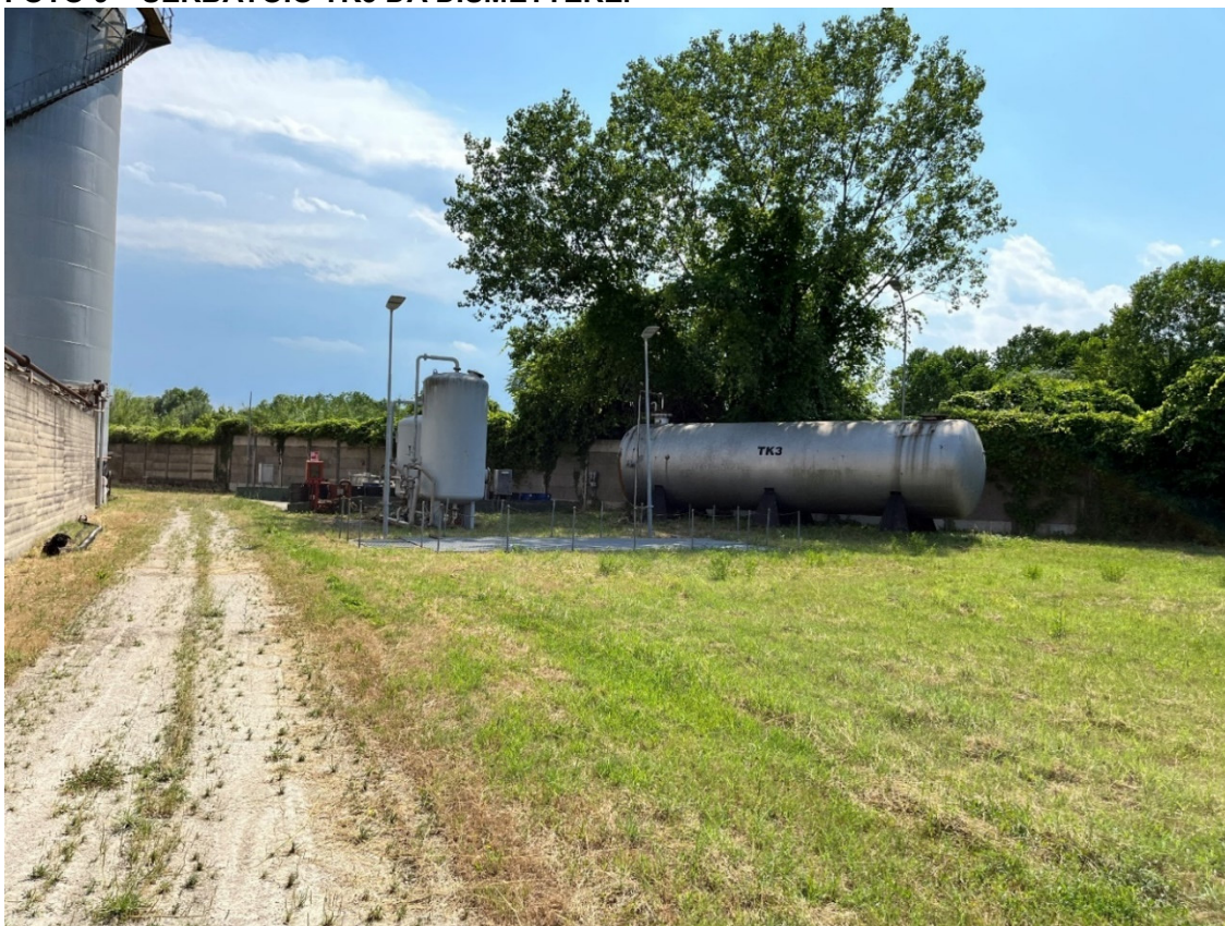
FOTO 9 – SERBATOIO TK3 DA DISMETTERE.
