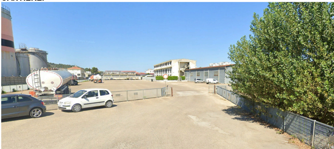
FOTO 7 – ZONA DI STOCCAGGIO TEMPORANEO DEI RIFIUTI DURANTE LA FASE DI CANTIERE.
