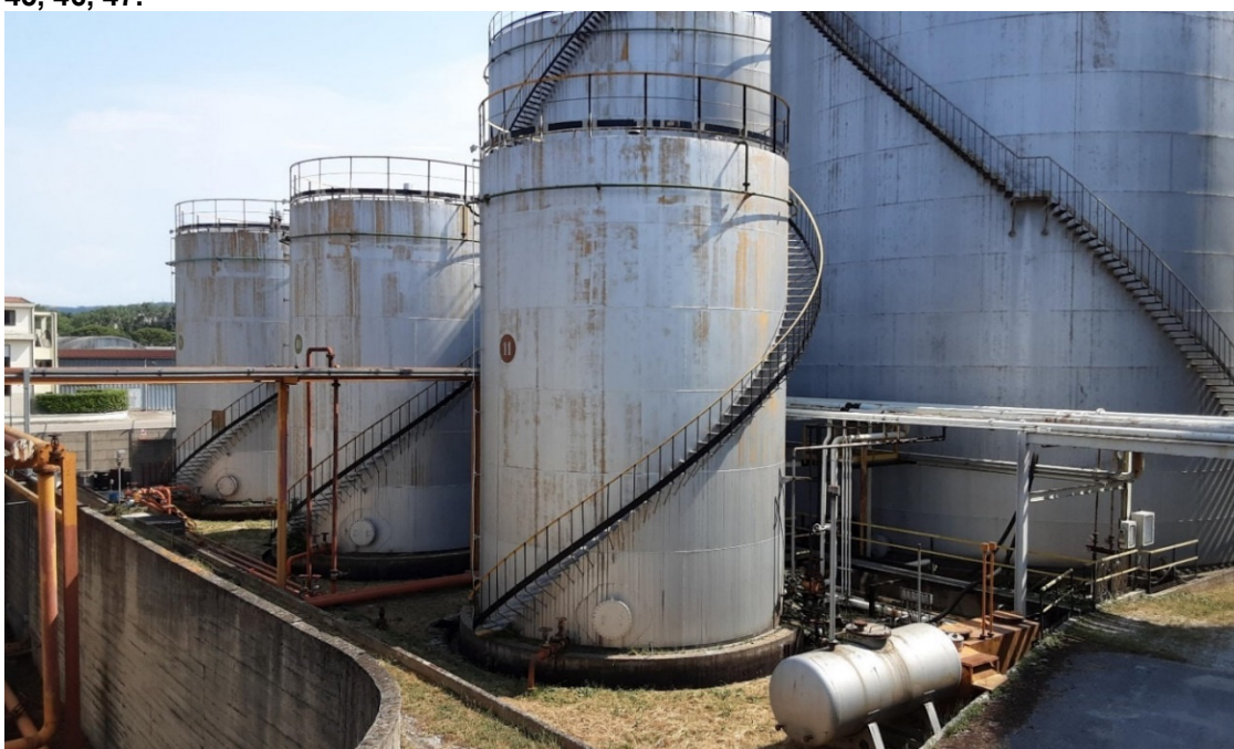
FOTO 10 – INQUADRAMENTO DALL'ALTO ZONA SERBATOI IN DISMISSIONE N. 9, 10, 11, 45, 46, 47.
