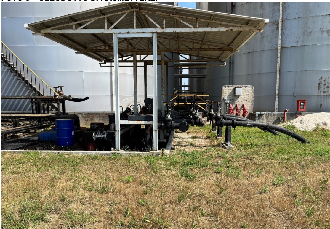
FOTO 8 – OLEODOTTO DA DISMETTERE.
