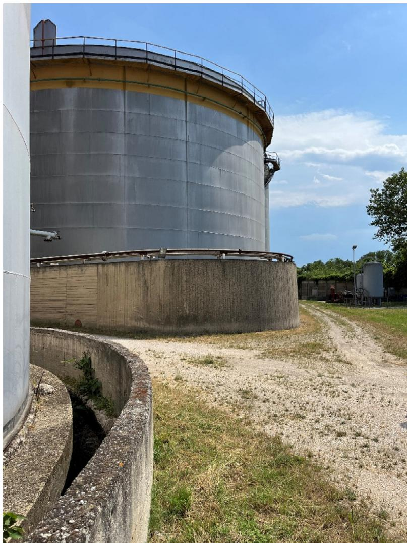
**Figura 5-9 – Bacini di contenimento in cemento armato**
