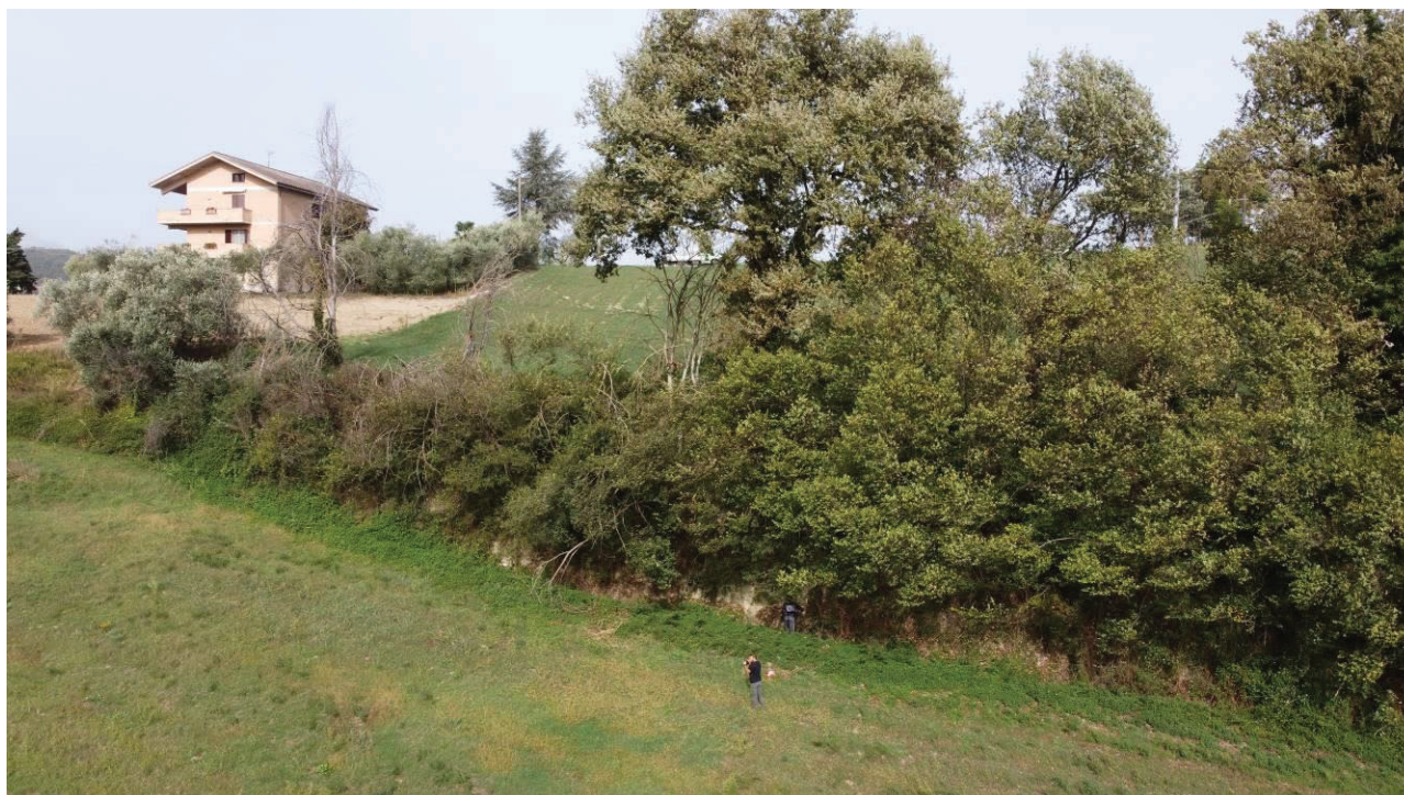
Figura 7-3 Area imbocco sud, evidente l'affioramento di LAG2c in corrispondenza della scarpata
