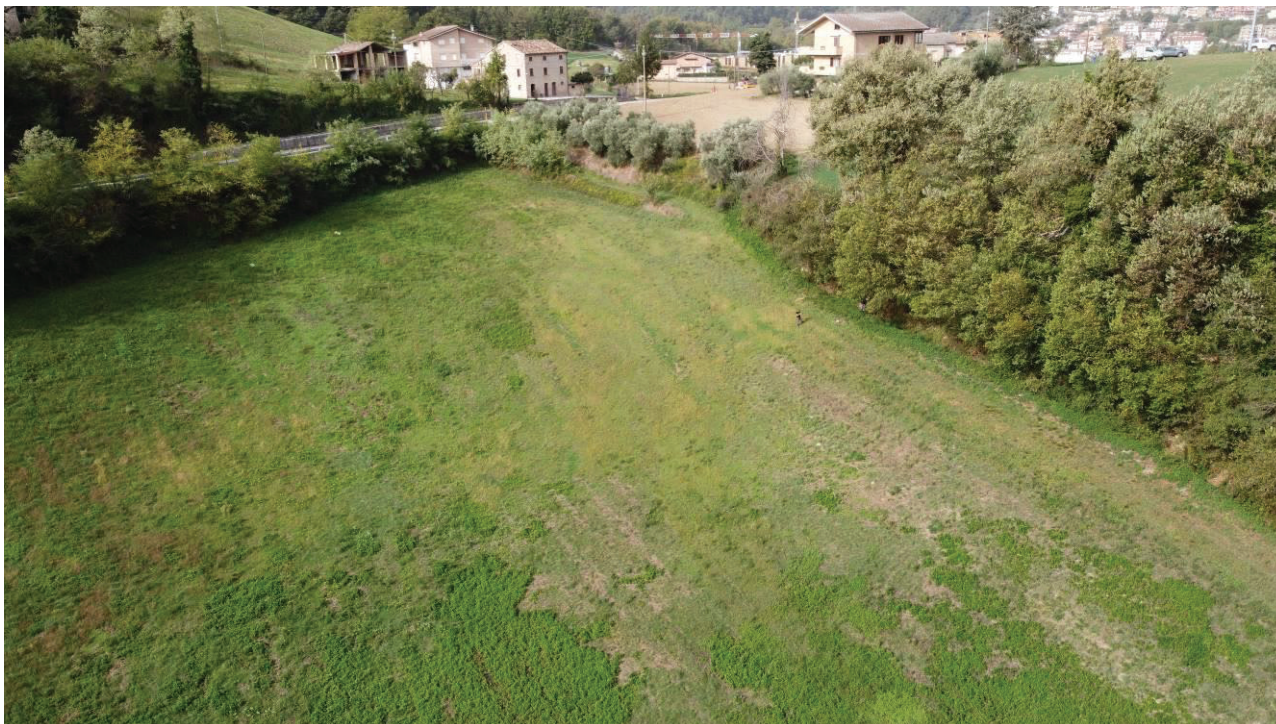
Figura 7-4 Foto del deposito di frana da colamento tra le p.k. 0+380.00 e p.k. 0+460.00.
