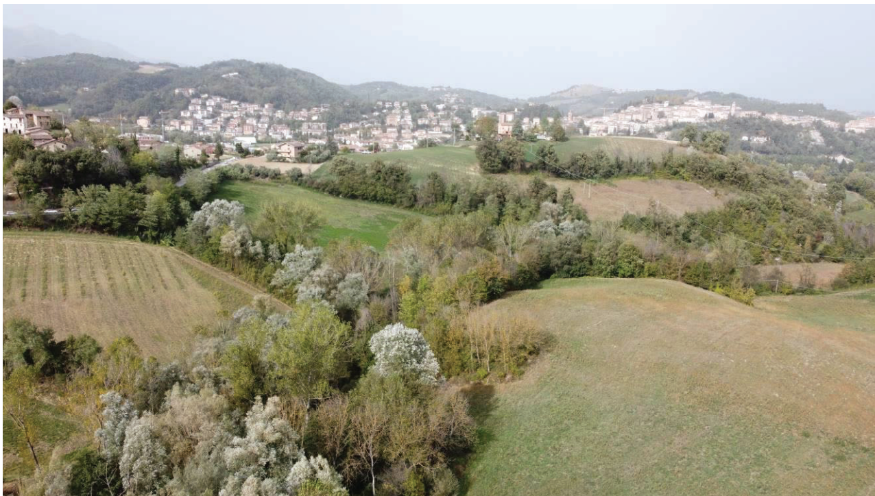
Figura 7-5 Area di passaggio del viadotto
