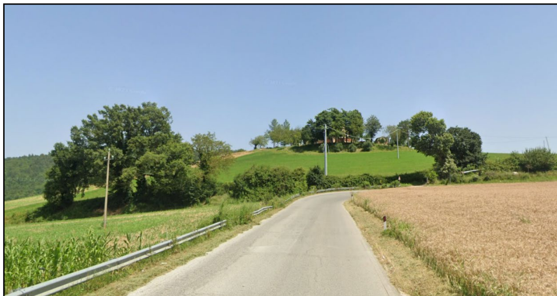
Figura 6-1 S.P. 237 Tratto nei pressi dell'ospedale di Amandola con curva a stretto raggio e problemi di visibilità
