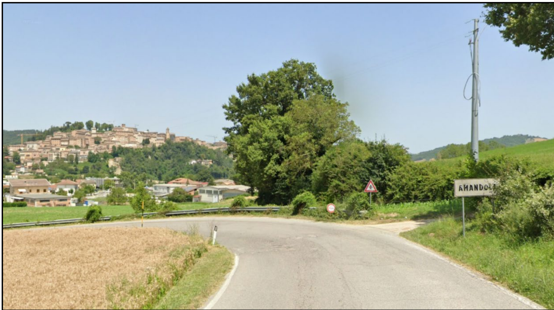
Figura 6-2 Accessi privati diretti in prossimità delle curve
