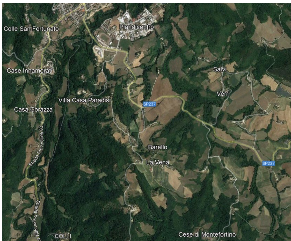
Figura 5-1 Infrastruttura stradale allo stato attuale
