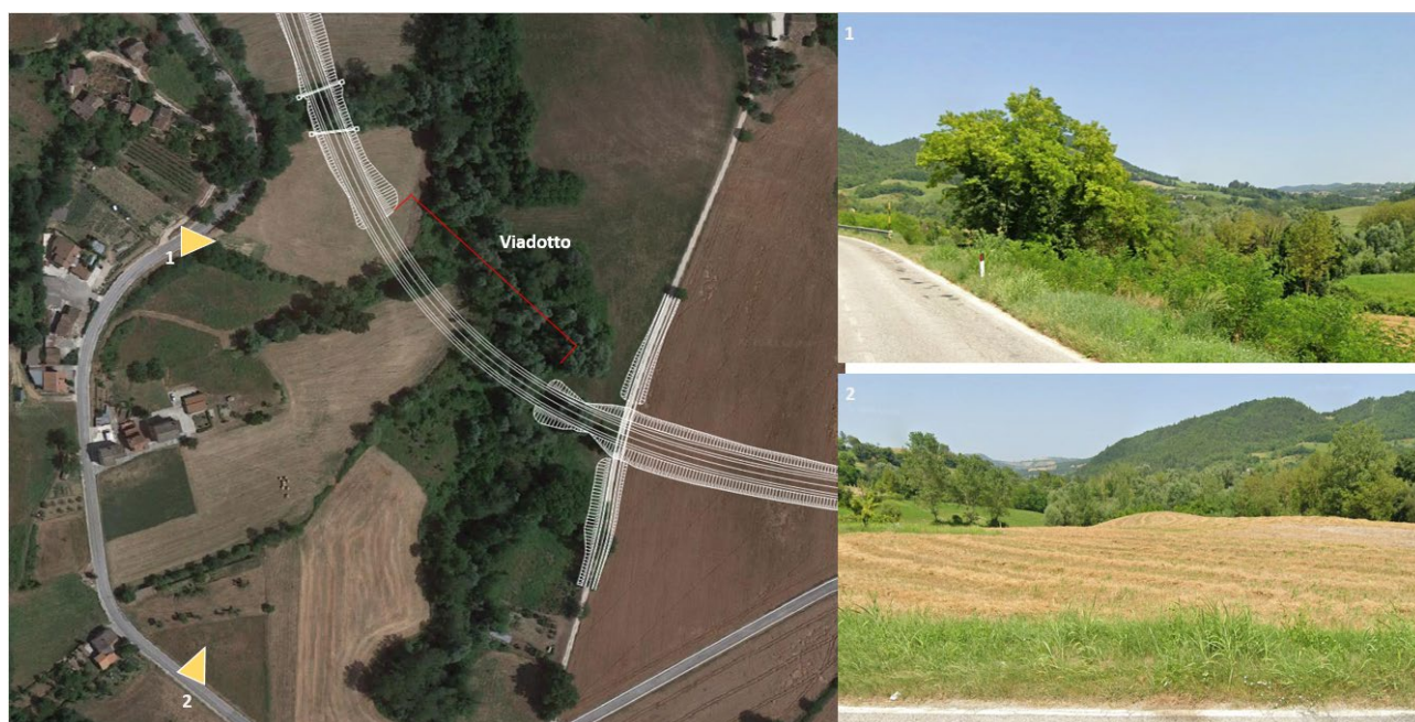
Figura 8-26 Il viadotto di progetto in prossimità dell'abitato di Ciaraglia
