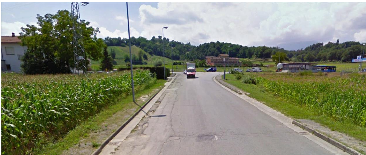
Foto 02 – Vista sud ovest
