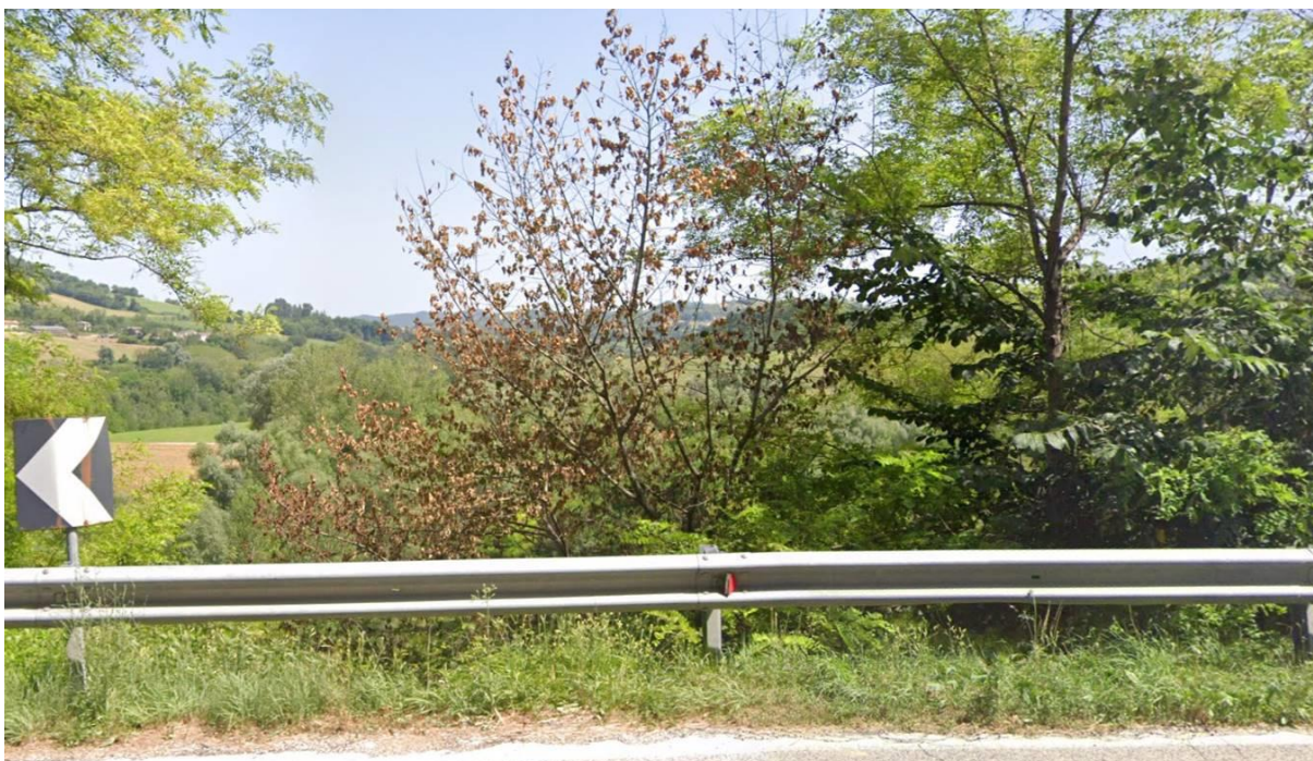
Foto 07 – Vista sud est
