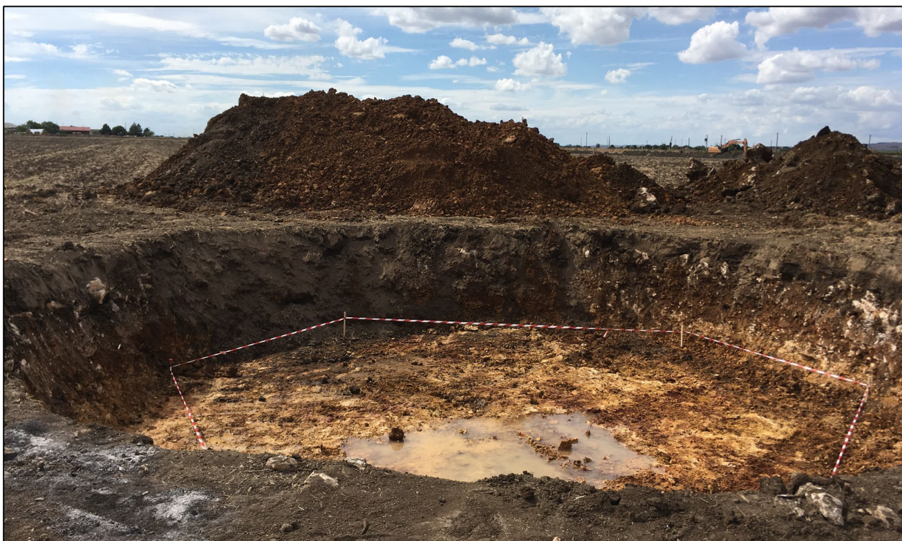
Scavo Fondazione Plinto Aerogeneratore
