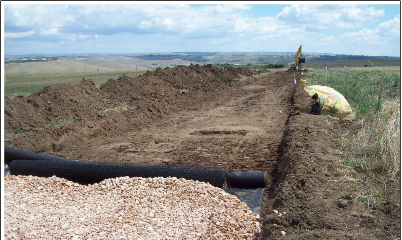
Viabilità di nuova realizzazione – Fase di scavo superficiale (scotico) con inizio di posa di massiciata e geogriglia
