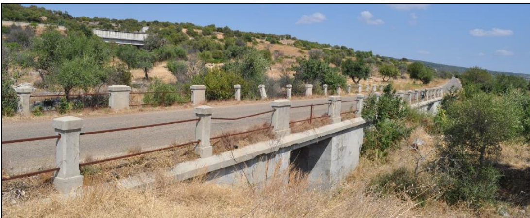
Foto del Ponte oggetto di intervento
