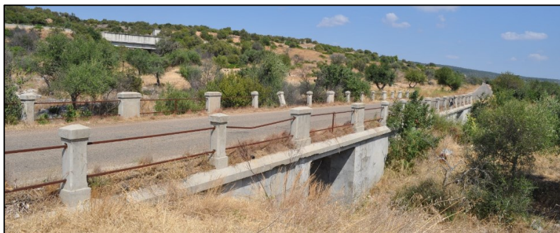
Foto del Ponte oggetto di intervento
