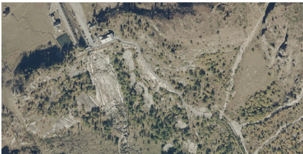
Stato Attuale dell'area oggetto di intervento
