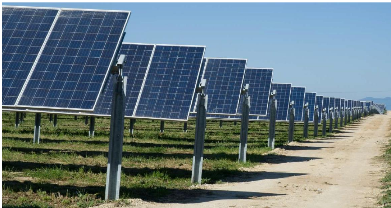
Figura 2 - immagine esemplificativa di inseguitori mono-assiali in configurazione 1P (fonte: ConvertItalia)
