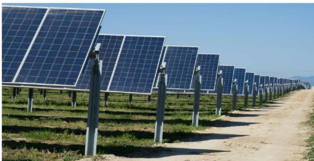
FIGURA 3.2 Immagine esemplificativa di inseguitori mono-assiali in configurazione 1P (fonte:ConvertItalia).
