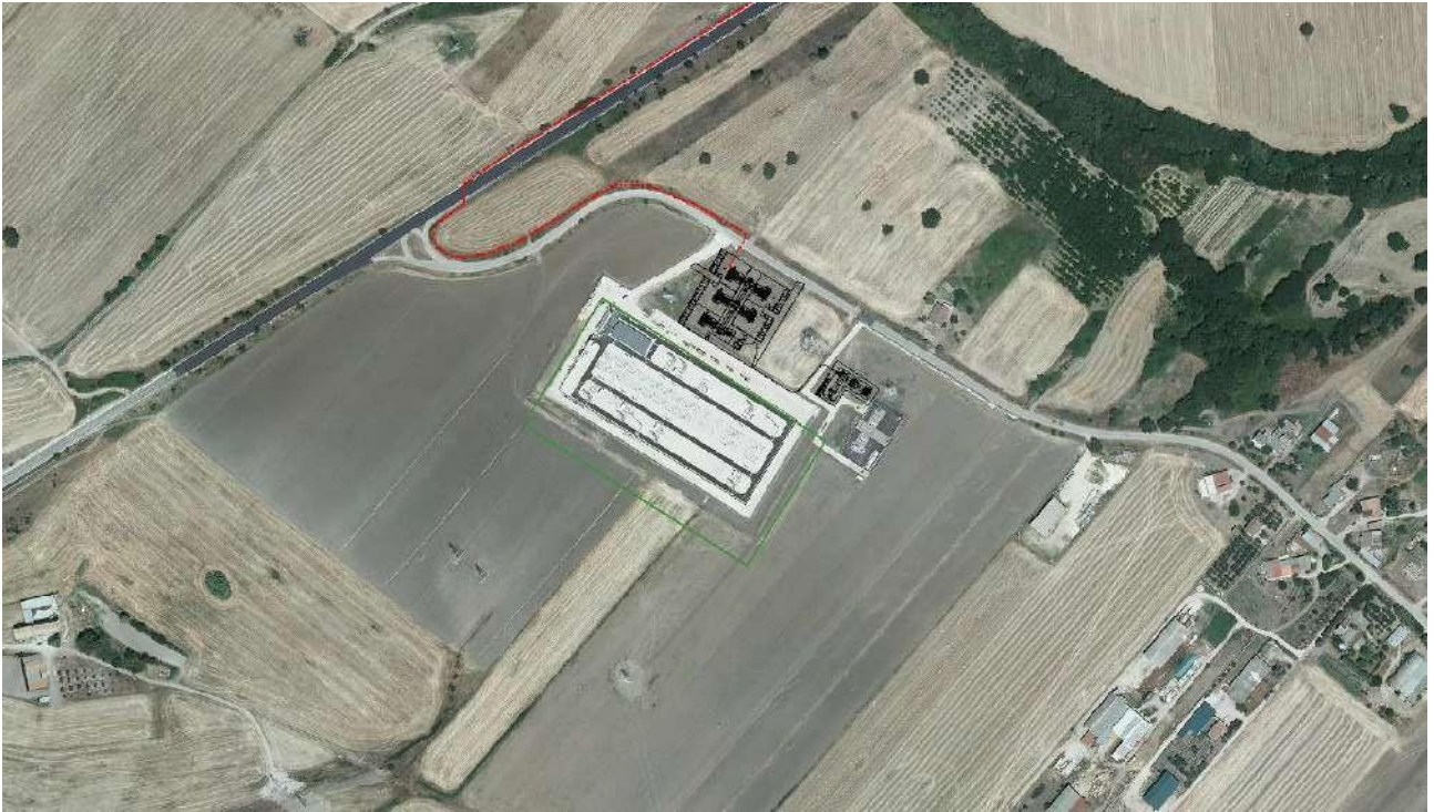
FIGURA 2.11.4 – CABINA ELETTRICA PRIMARIA E-DISTRIBUZIONE SU ORTOFOTO
