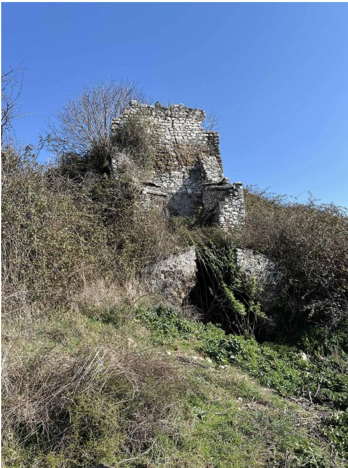
Foto 4. Antico forno in pietra per la calce nei pressi dell'area del cantiere PZ1
