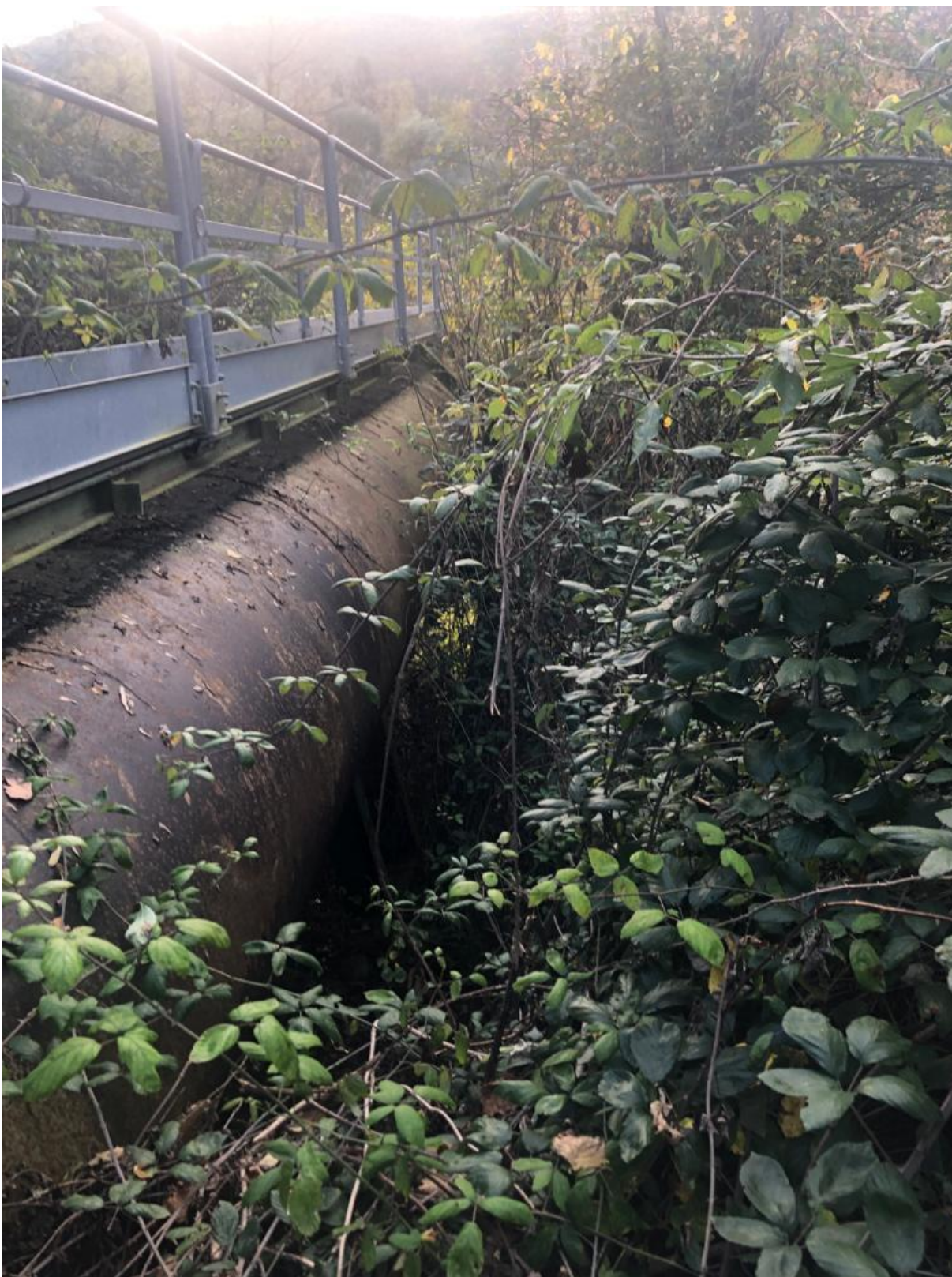
Foto 2. Condizioni della vegetazione in corrispondenza del ponte tubo in sponda destra del fiume Aniene alla fine del mese di novembre 2023
