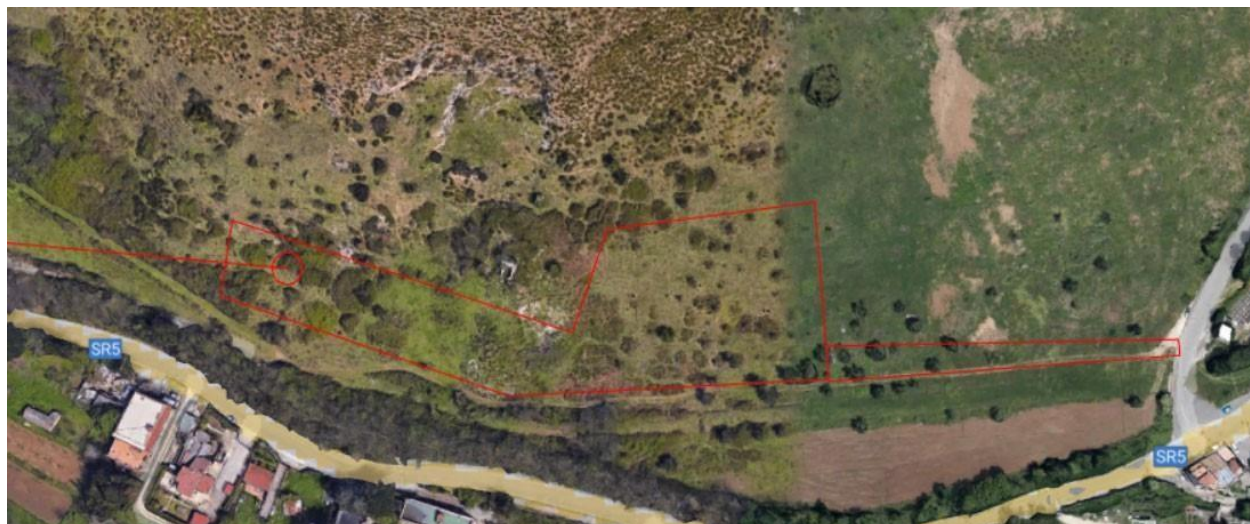
Figura 5. Inquadramento territoriale area cantiere PZ1
