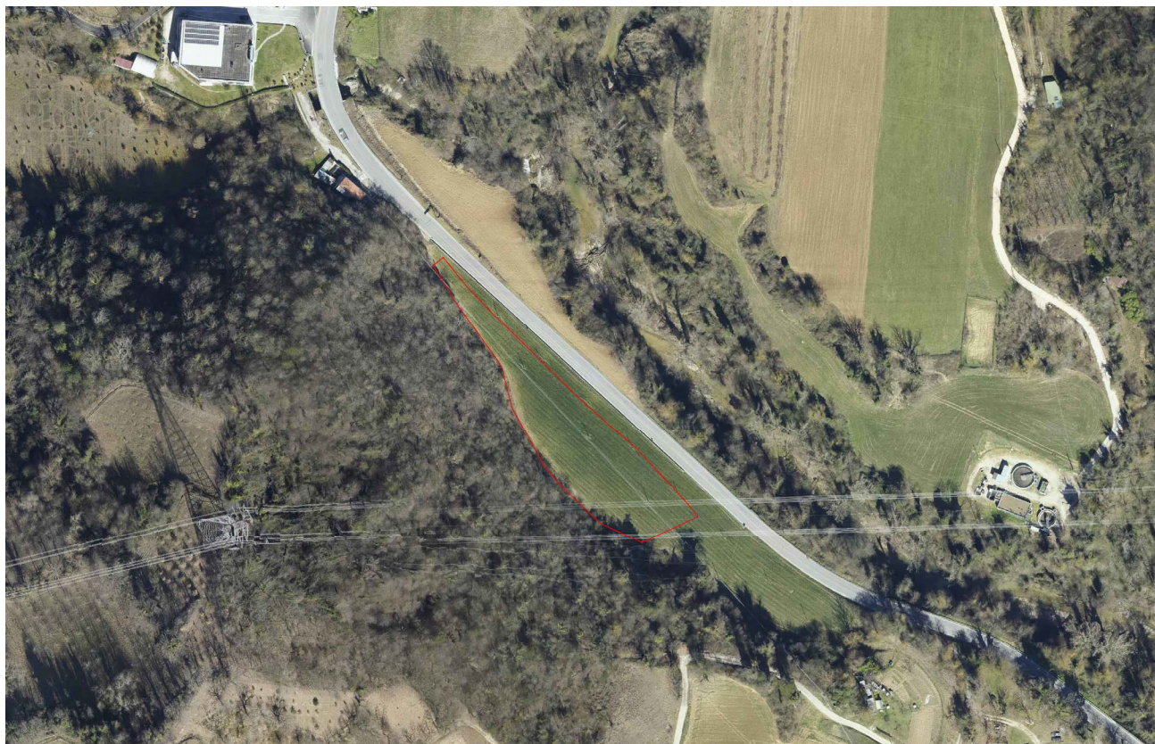
Fig. 10.3 – Ubicazione area di cantiere n° 2
