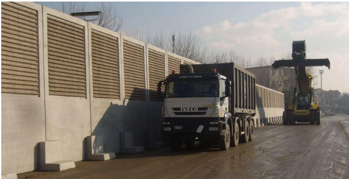
Fig. 7 - immagine di esempio di installazione di una barriera mobile
