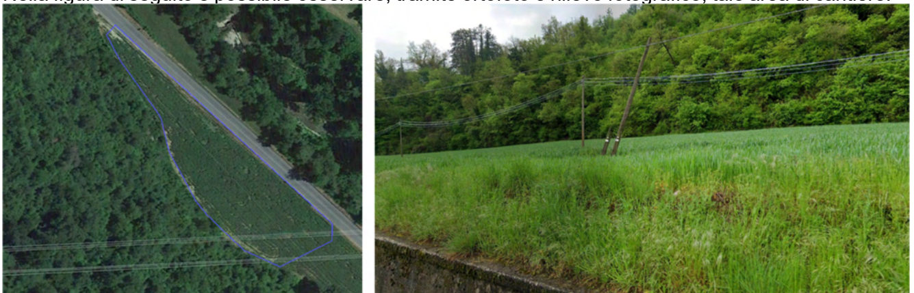
Figura 7-2 Localizzazione e caratterizzazione del cantiere operativo A
