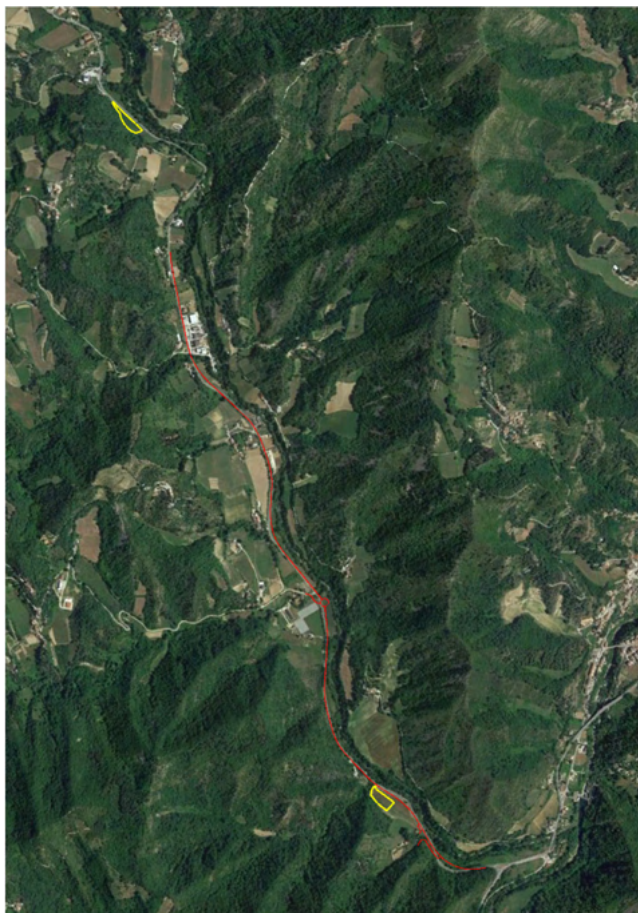
Figura 7-15 La localizzazione dei cantieri Campo Base 1 e Cantiere Operativo A in rapporto alla Valle del Fluvione, a sud di Marsia e in prossimità dell'incrocio della S.S. 78 con la SS4
