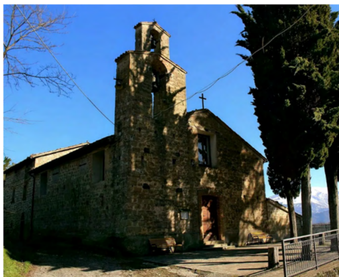
Figura 5-33 Chiesa di San Nicola e San Flavio, ora di Santi Nicola e Ilario, in Via Fonte dei Pioppi, Comune di Roccafluvione
