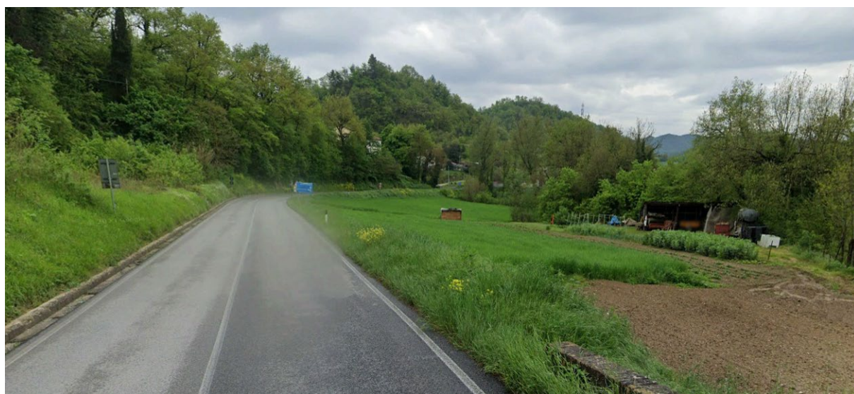
Foto 03 – Vista nord ovest
