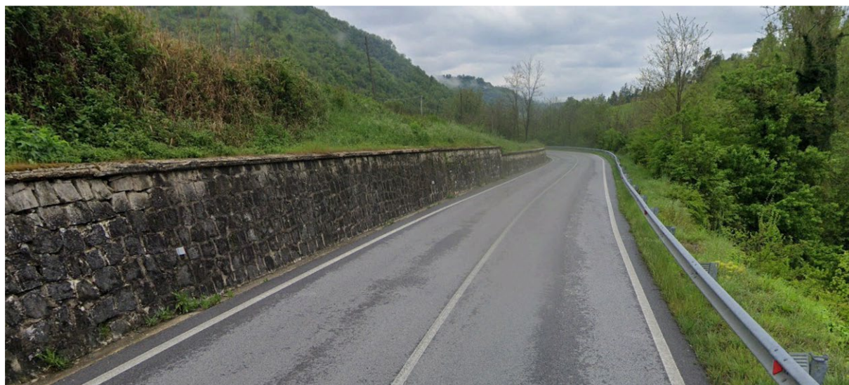
Foto 09 – Vista nord ovest
